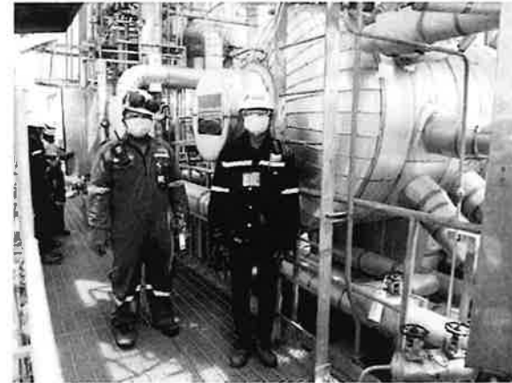
ภาพที่ 5 ภาพถ่ายร่วมกับ ผู้ควบคุมประจำหม้อไอน้ำ ที่บริเวณ Boiler Drum ขณะทำการฉีดน้ำ Hydrostatic Test เพื่อทำการทดสอบหม้อไอน้ำ
