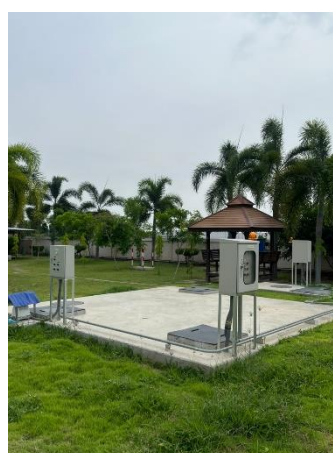
รูปที่ 11 ระบบบำบัดน้ำเสียสำเร็จรูป ขนาด 10 ลูกบาศก์เมตร
