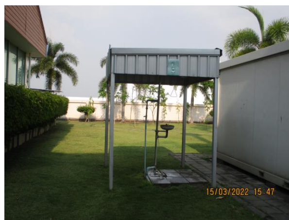
รูปที่ 29 อ่างล้างตา และฝักบัวฉุกเฉิน
