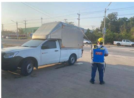
รูปที่ 4 การทำความสะอาดล้อรถบรรทุก
