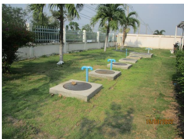
รูปที่ 11 ระบบบำบัดน้ำเสียสำเร็จรูป ขนาด 10 ลูกบาศก์เมตร
