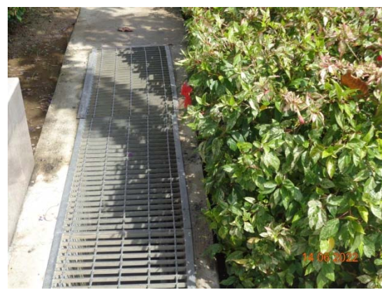
รูปที่ 27 รางระบายน้ำฝรอบโรงไฟฟ้า
