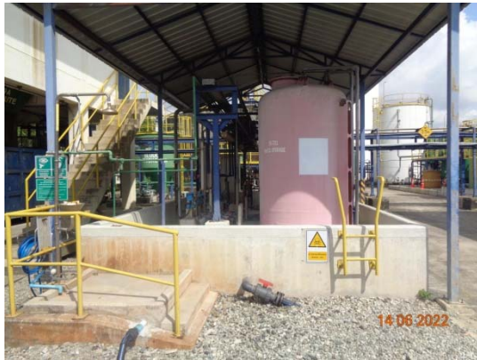
รูปที่ 73 คันคอนกรีตล้อมรอบที่เก็บสารเคมี
