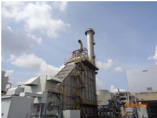
รูปที่ 1 ปล่อง HRSG # 1 (Unit 400)
