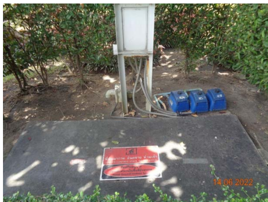
รูปที่ 28 ระบบบำบัดน้ำเสียสำเร็จรูป (Septic Tank) บริเวณอาคารสำนักงาน
