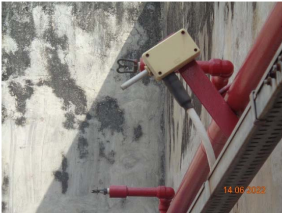
รูปที่ 56 ระบบตรวจจับควัน
