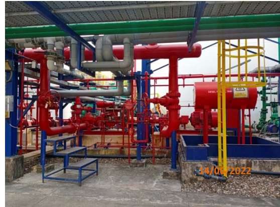
รูปที่ 80 เครื่องสูบน้ำดับเพลิง
