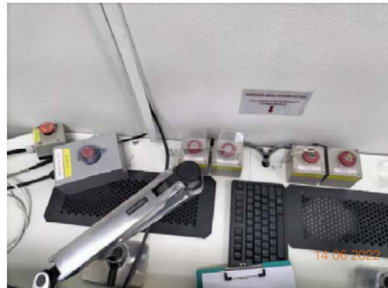
รูปที่ 86 ปุ่ม Emergency shutdown
