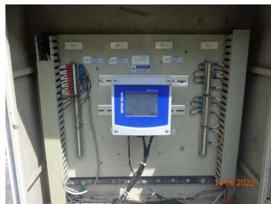
รูปที่ 23 เครื่องแสดงผลการตรวจวัดค่าความเป็น กรด-ด่าง อุณหภูมิ และค่าความนำไฟฟ้าแบบ อัตโนมัติ
