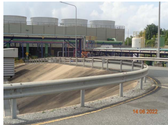
รูปที่ 31 แนว Barrier กัน เพื่อป้องกันรถหลุดออกนอกเส้นทาง
