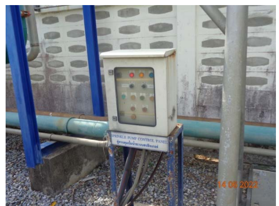
รูปที่ 29 ตู้ควบคุมปั๊มน้ำทิ้งกลับมาใช้รดน้ำต้นไม้
