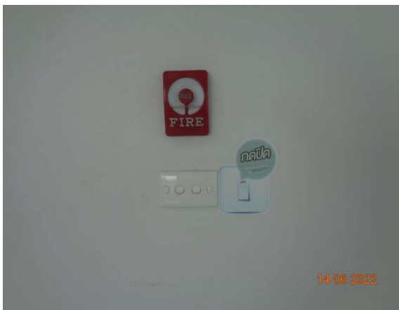
รูปที่ 83 ปุ่มแจ้งเหตุเพลิงไหม้
