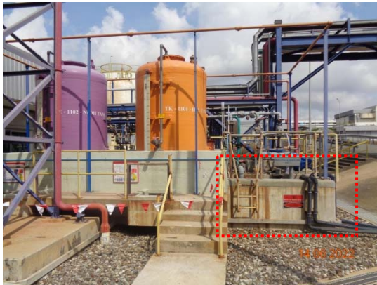
รูปที่ 18 ถังปรับสภาพน้ำให้เป็นกลาง (Neutralization pit)
