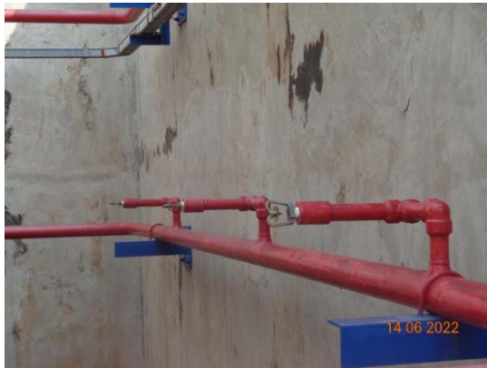
รูปที่ 79 ระบบหัวกระจายน้ำแบบแห้งอัตโนมัติ
