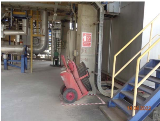
รูปที่ 75 ถังดับเพลิงแบบรถเข็น
