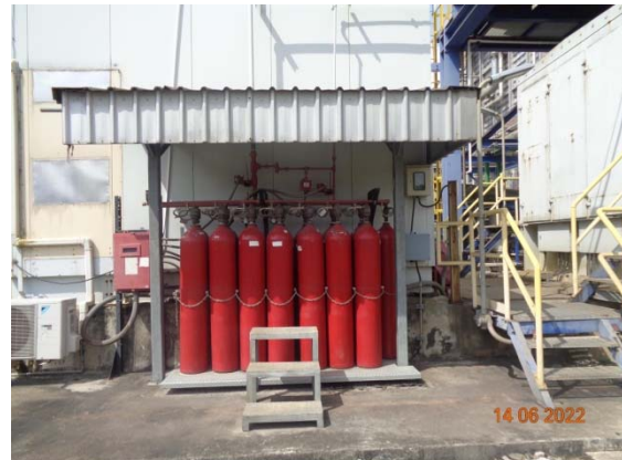
รูปที่ 82 ระบบฉีดก๊าซคาร์บอนไดออกไซด์แบบอัตโนมัติ
