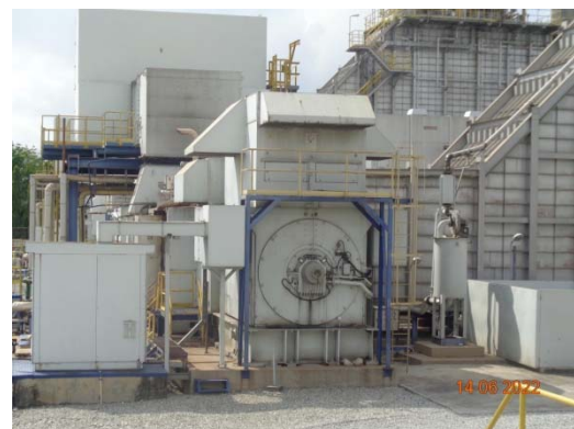
รูปที่ 12 ครอบปกคลุม (Insulation) บริเวณที่มีเสียงดัง
