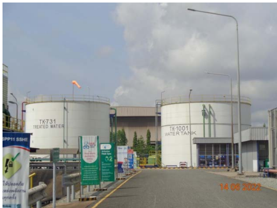
รูปที่ 81 ถังเก็บน้ำดับเพลิงสำรอง
