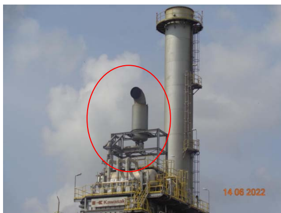
รูปที่ 16 ตัวเก็บเสียง (Silencer) บริเวณ Safety release valve
