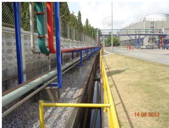
รูปที่ 26 รางระบายน้ำทิ้งของโรงไฟฟ้า
