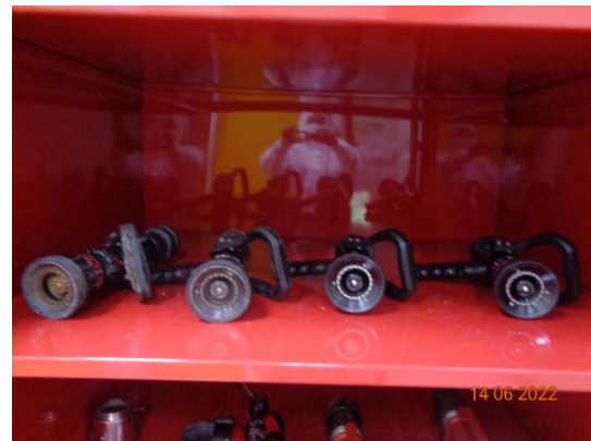
รูปที่ 76 หัวฉีดน้ำดับเพลิง
