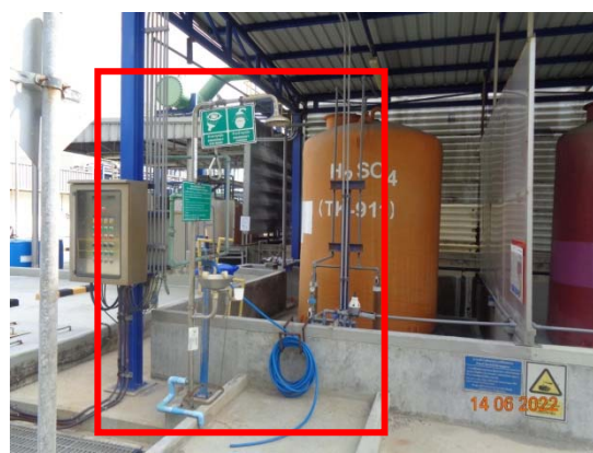
รูปที่ 70 อ่างล้างตาฉุกเฉินและฝักบัวฉุกเฉิน
