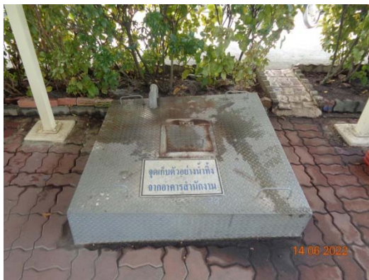
รูปที่ 20 บ่อตรวจสอบคุณภาพน้ำที่จากอาคารสำนักงาน
