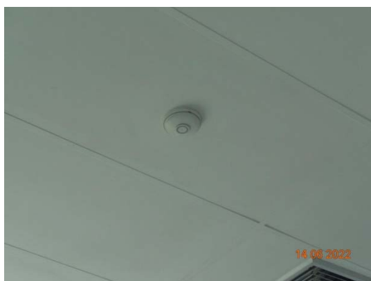
รูปที่ 54 ระบบตรวจจับควัน
