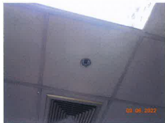
รูปที่ 60 smoke detector และ automatic sprinkler (อุปกรณ์ตรวจจับควันและความร้อน)
