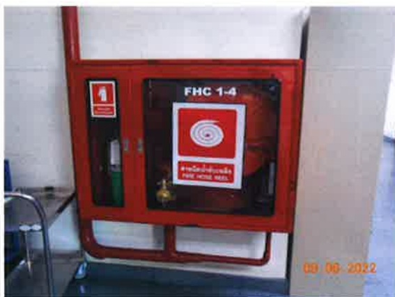
รูปที่ 61 ตู้เก็บอุปกรณ์ดับเพลิงแบบมือถือ
