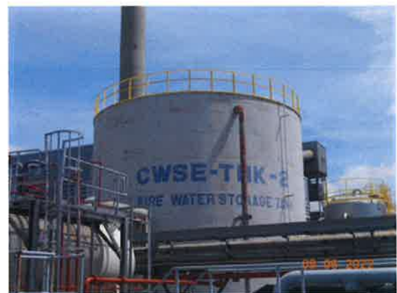
รูปที่ 62 ถังเก็บน้ำสำรองสำหรับดับเพลิง
