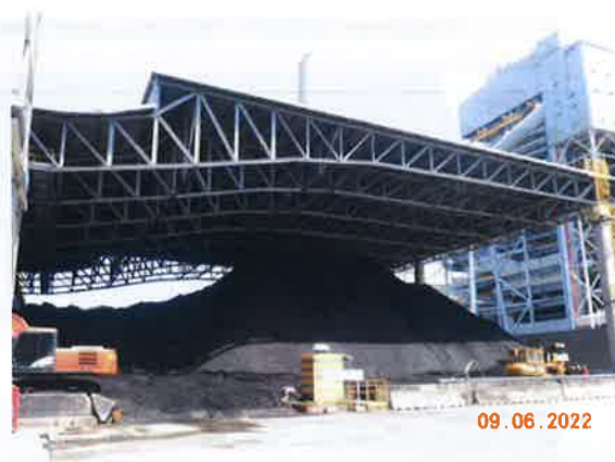
รูปที่ 43 ลานกองชีวมวลที่มีหลังคาปิดคลุม (ปัจจุบันใช้เป็นลานกองถ่านหิน)
