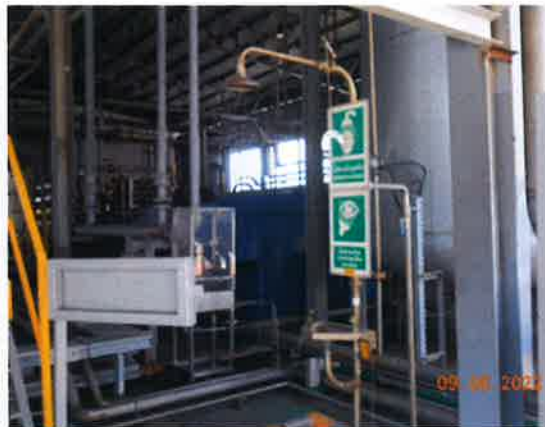
รูปที่ 59 อ่างล้างตาและร่างกายฉุกเฉิน
