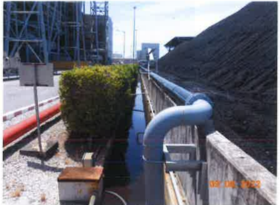
รูปที่ 29 รางรวบรวมน้ำรอบลานกองถ่านหิน
