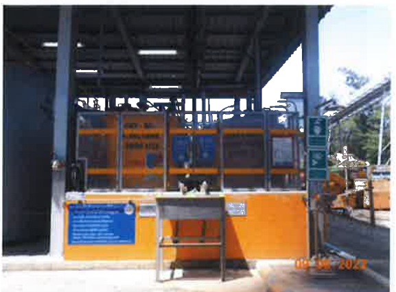
รูปที่ 31 ระบบบำบัดน้ำเสียแบบเคมี
