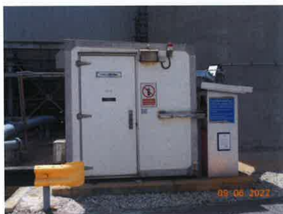
รูปที่ 16 ตัวอย่าง Analyzer House ของ CFB 1
