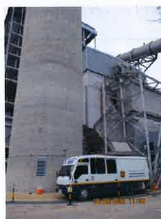
รูปที่ 17 การติดตามตรวจสอบระบบ CEMs ของปล่องระบายอากาศ CFB 1
