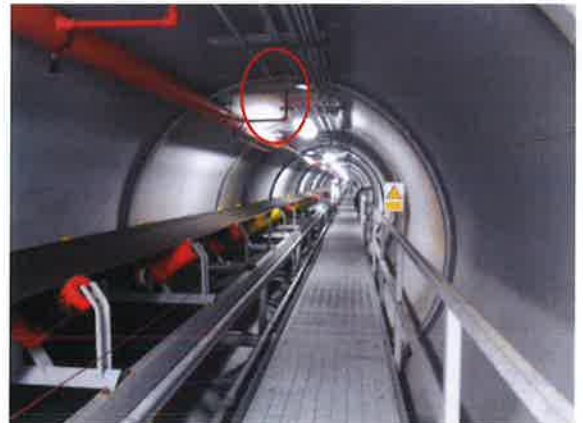
รูปที่ 66 อุปกรณ์ป้องกันอัคคีภัย บริเวณสายพานลำเลียง
