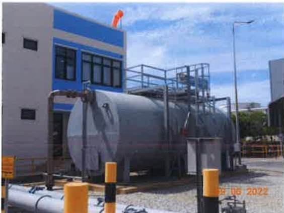
รูปที่ 28 ระบบแยกน้ำ-น้ำมัน
