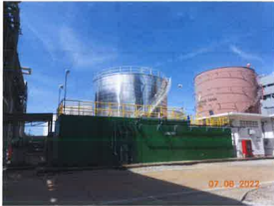
รูปที่ 26 ระบบบำบัดน้ำเสียทางชีวภาพ จากห้องน้ำ-ห้องส้วม
