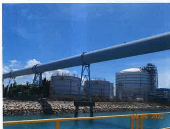
รูปที่ 6 แนวสายพานลำเลียงถ่านหินแบบปิด
