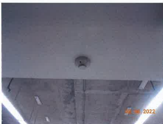
รูปที่ 60 smoke detector และ automatic sprinkler (อุปกรณ์ตรวจจับควันและความร้อน)
