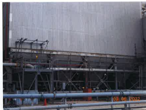
รูปที่ 15 ระบบดักจับฝุ่นแบบถุงกรองอากาศเสีย (Baghouse filter)
