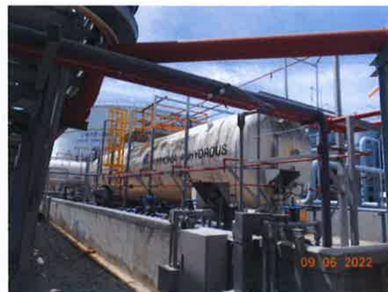
รูปที่ 54 ถังเก็บกักแอมโมเนียและระบบสเปรย์น้ำ รอบถังเก็บกัก
