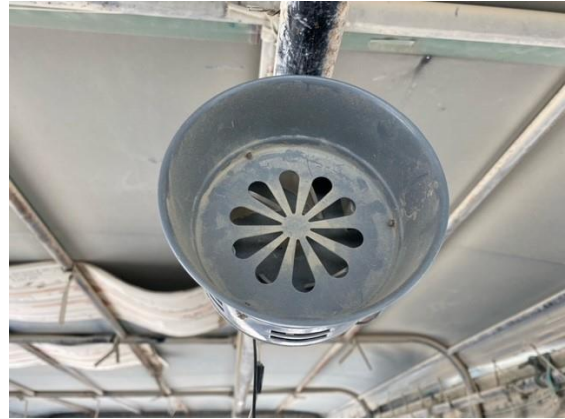
รูปที่ 12 ไซเรนสัญญาณเตือนภัยก่อนการระเบิด
