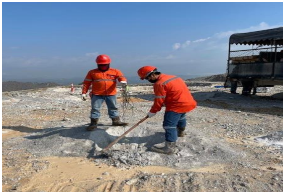
รูปที่ 13 การอุดปากระเบิด
