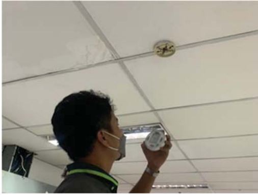
การตรวจเช็คระบบป้องกันและแจ้งเตือนอัคคีภัย
