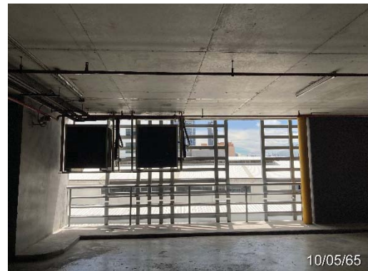
ระบบระบายอากาศชั้นจอดรถ
