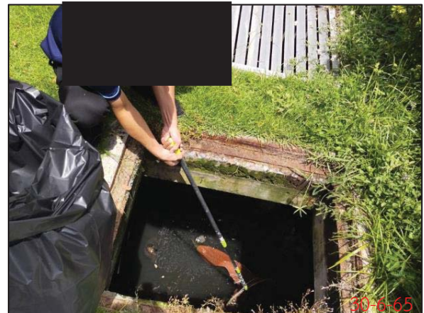
ทำความสะอาดขุดลอก Manhole และท่อระบายน้ำภายในโครงการ
