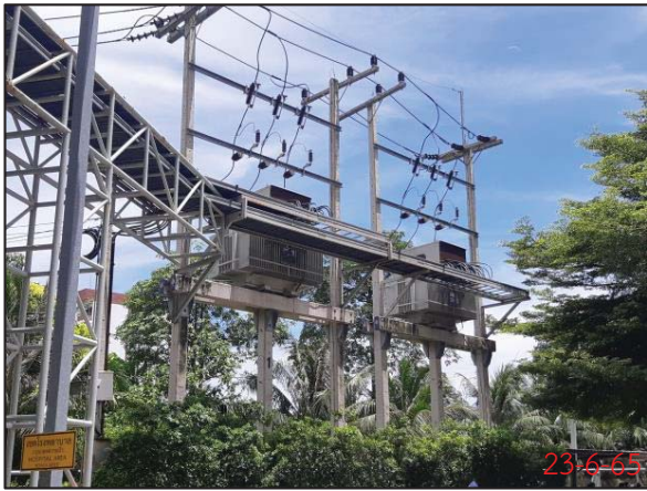
หม้อแปลงไฟฟ้าสำหรับอาคารโรงพยาบาล และอาคารหอพักพยาบาล
