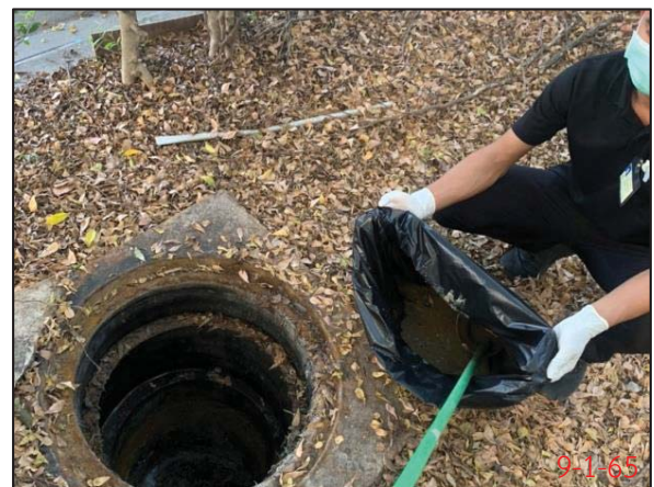
การตัดกากไขมันออกจากบ่อดักไขมัน
