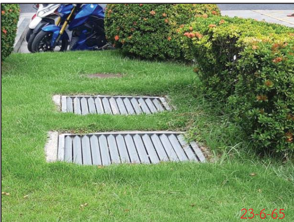
ตะแกรงดักมูลฝอยบริเวณบ่อดัก ก่อนเข้าสู่บ่อบำบัดน้ำ
