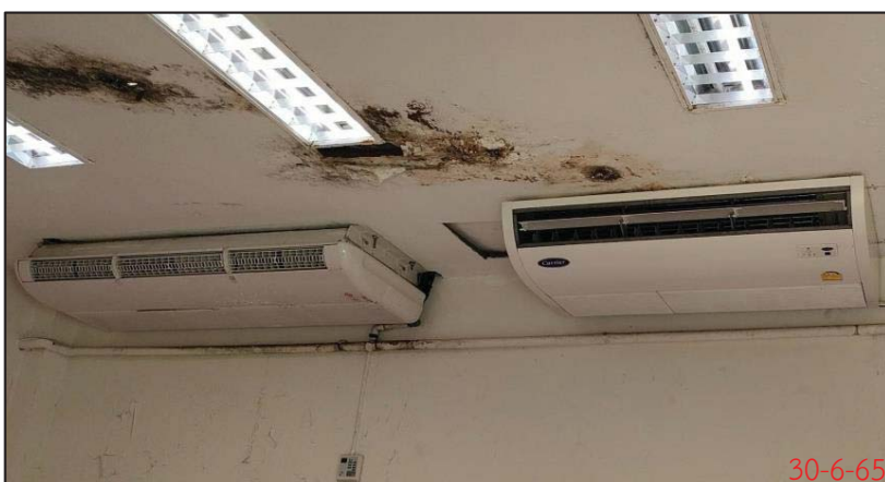
การปรับอุณหภูมิติดตั้งเครื่องปรับอากาศในห้องพักมูลฝอยติดเชื้อ
