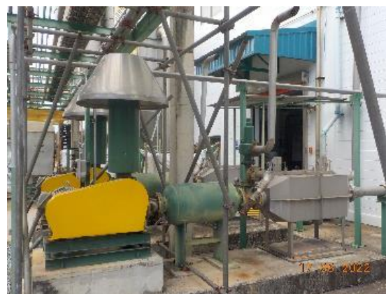
ภาพถ่ายที่ 2.2-23 อุปกรณ์ลดความดังของเสียง Silencer
