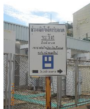
ภาพถ่ายที่ 2.2-10 บัตรวัดก๊าซคาร์บอนิลคลอไรด์ (CG Badge) และป้ายบังคับติดบัตรก่อนเข้าส่วนผลิต
