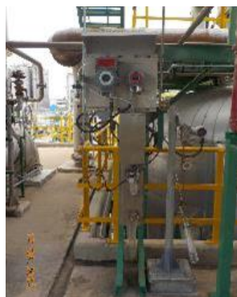
ภาพถ่ายที่ 2.2-14 HE Analyzer เพื่อตรวจสอบ Heptane ฆ่าเชื้อ HE Detector
