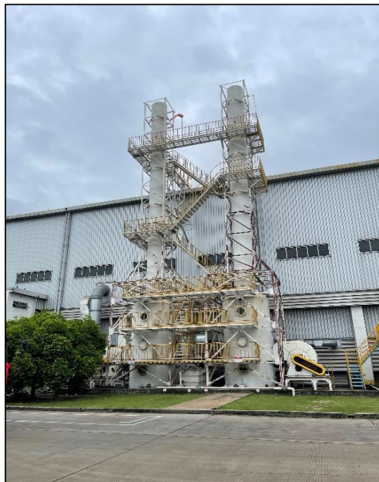
ภาพที่ 2.2 ระบบบำบัดมลพิษทางอากาศ (ระบบดักฝุ่นเปียก Wet Scrubber)
