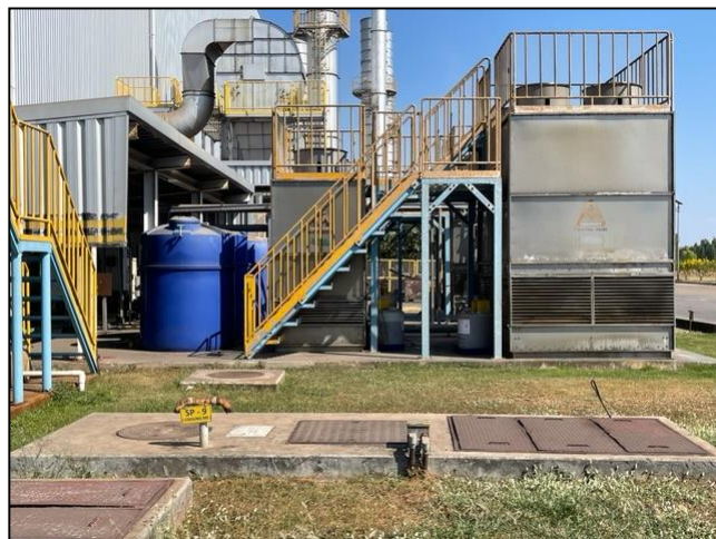
ภาพที่ 2.16 การระบบน้ำหล่อเย็น (Cooling System) และระบบน้ำทิ้งจากระบบ RO
