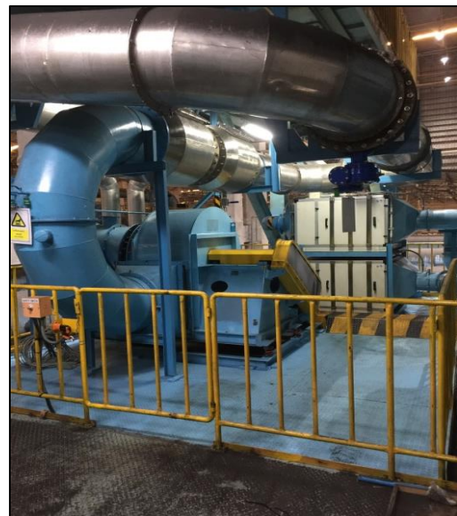
ภาพที่ 2.45 ติดตั้งระบบบำบัดกลิ่นแบบพลาสมาเย็น (Cold Plasma)
