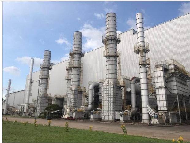
ภาพที่ 2.1 ระบบบำบัดมลพิษทางอากาศ (ระบบดักฝุ่นแบบถุงกรอง Bag Filler)
