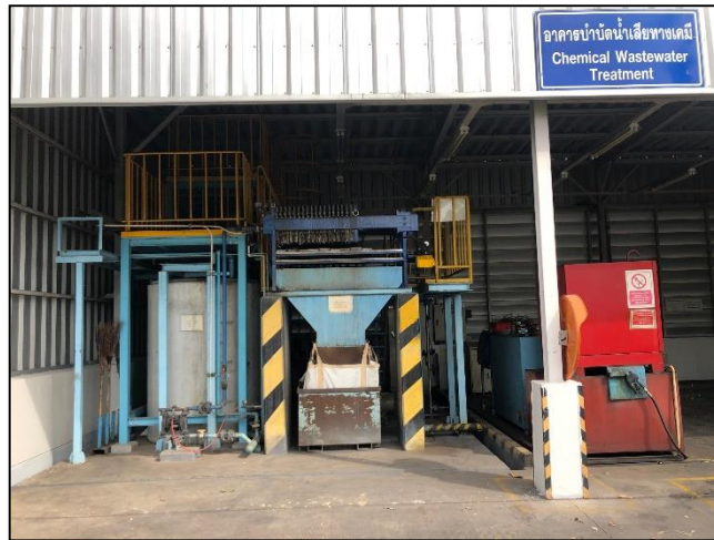
ภาพที่ 2.14 การติดตั้งปรับปรุงระบบบำบัดน้ำเสียแบบตกตะกอนทางเคมี
