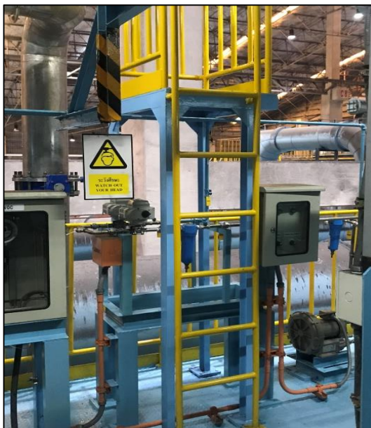
ภาพที่ 2.3 ติดตั้งระบบบำบัดกลิ่นแบบพลาสมาเย็น (Cold Plasma)
