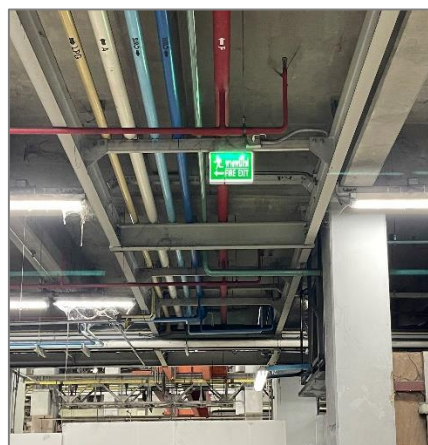
ภาพที่ 2.39 ติดตั้งระบบป้องกัน และระงับอัคคีภัย บริเวณอาคารผลิต
