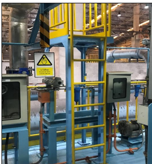
ภาพที่ 2.45 ติดตั้งระบบบำบัดกลิ่นแบบพลาสมาเย็น (Cold Plasma)
