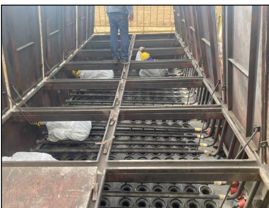
ภาพที่ 2.6 การเปลี่ยนถุงกรองของระบบ Bag filter
