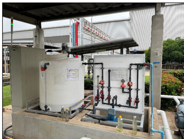
ภาพที่ 2.13 การติดตั้งปรับปรุงระบบบำบัดน้ำเสียในส่วนของการเติมอากาศ
