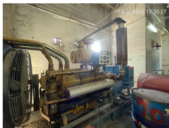
รูปที่ 57 เครื่องกำเนิดไฟฟ้าสำรอง (Diesel Generator)
