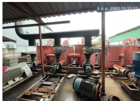
เครื่องสูบน้ำดับเพลิง (ปั๊มมอเตอร์)
