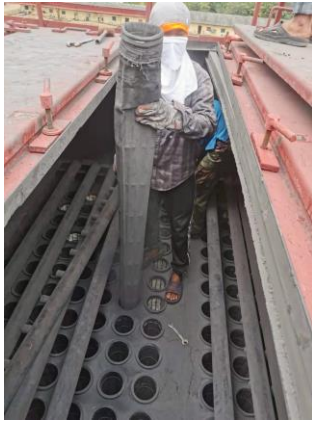
รูปที่ 7 การดำเนินการเปลี่ยนถุงกรองครั้งล่าสุด
