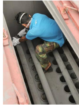
รูปที่ 7 การดำเนินการเปลี่ยนถุงกรองครั้งล่าสุด
