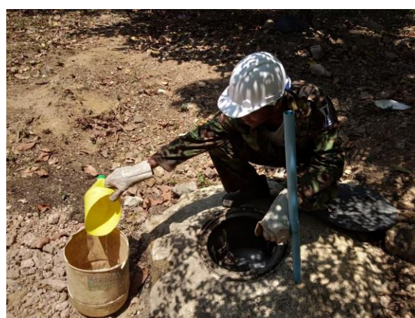
รูปที่ 19 เจ้าหน้าที่ตรวจสอบดูแลถังไขมันและตะกอนจากถังดักไขมัน
