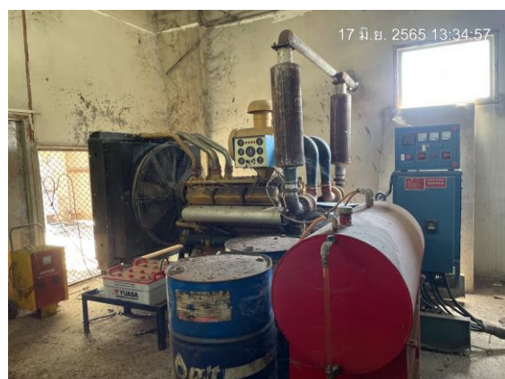
รูปที่ 57 เครื่องกำเนิดไฟฟ้าสำรอง (Diesel Generator)
