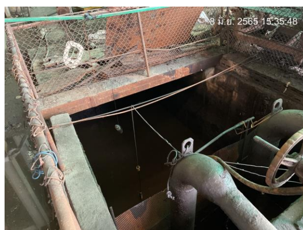
รูปที่ 21 การขุดลอกตะกอนบ่อดักไขมัน/ บ่อดักตะกอน
