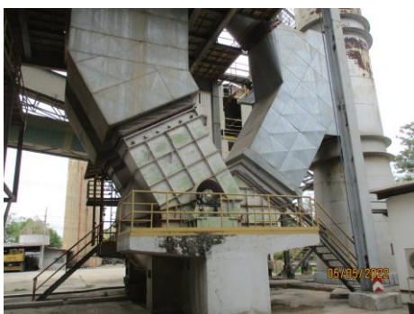
รูปที่ 13 การติดตั้ง Damper ที่ท่อลมของ EP
