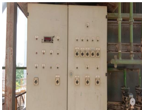
รูปที่ 7 ระบบเตือน (Alarm) ของ CO/O 2 Analyzer
