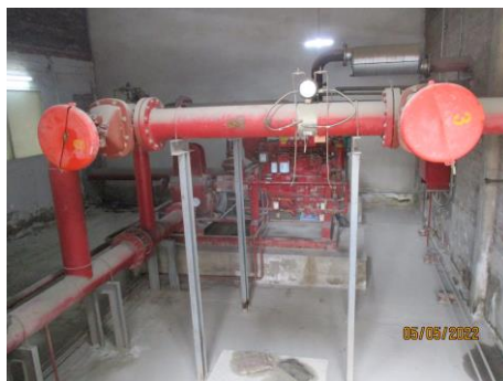
รูปที่ 53 ปิมน้ำดับเพลิงสำรอง
