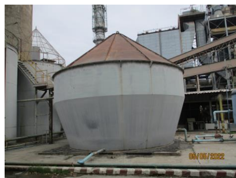
รูปที่ 28 ถังตกตะกอนของระบบประปา
