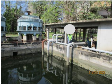
รูปที่ 23 บ่อพักน้ำทิ้งจากระบบหล่อเย็น
