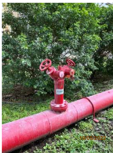
หัวจ่ายน้ำดับเพลิง รูปที่ 2-22 (ต่อ) อุปกรณ์ในการระงับเหตุอัคคีภัย
