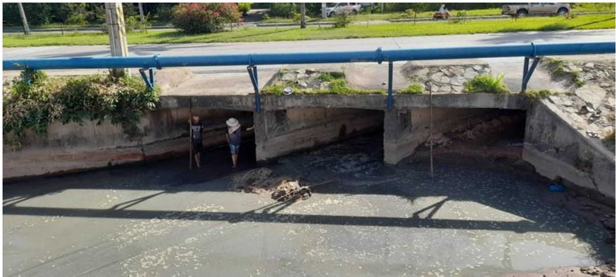
ภาพหลังดำเนินการขุดลอกตะกอนในรางระบายน้ำฝน
