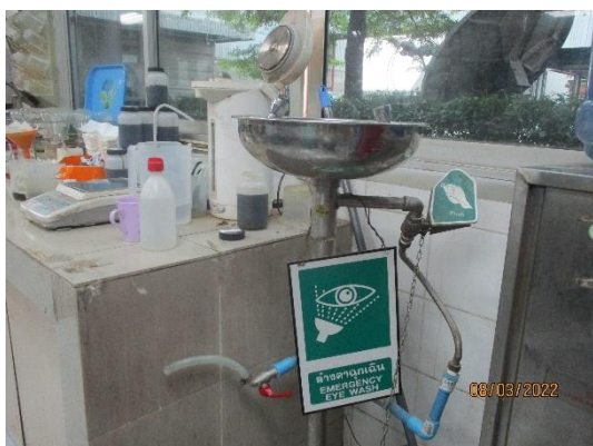
รูปที่ 44 ฝักบัวและอ่างล้างตา
