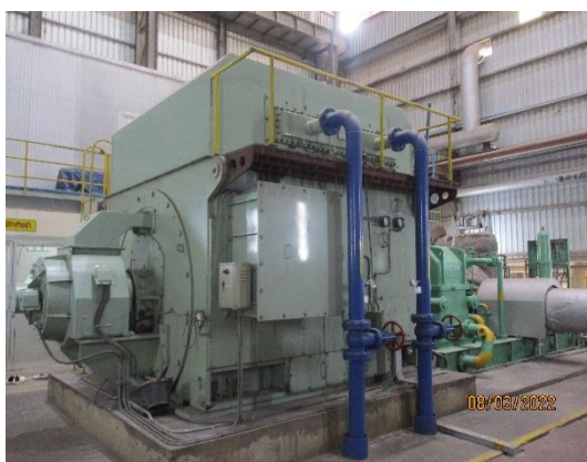
รูปที่ 57 เครื่องกำเนิดไฟฟ้า
