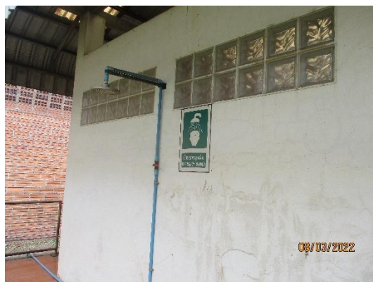
รูปที่ 44 ฝักบัวและอ่างล้างตา
