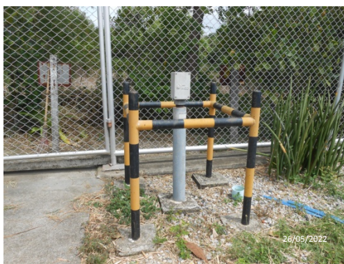
รูปที่ 3-3 ระบบวาล์วใต้ดินเพื่อสามารถตัดแยกระบบกรณีเกิดเหตุฉุกเฉิน
