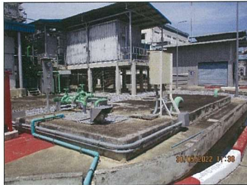
รูปที่ 2.2-16 ถังแยกน้ำ-น้ำมัน (Oil Separator)
