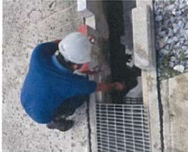
นักเคมีตรวจวัด pH และตรวจสอบคุณภาพน้ำ 3 จุด ได้แก่ 1) จุดเกิดเหตุ 2) รางระบายน้ำก่อนออกจากโรงไฟฟ้า 3) ประตุน้ำหลักหน้าโรงไฟฟ้า พบว่า "น้ำอยู่ในเกณฑ์มาตรฐาน"
