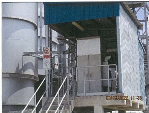
รูปที่ 2.2-3 ระบบ CEMs ของปล่องระบายทั้ง 2 ปล่อง
