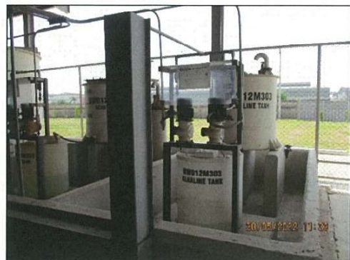
รูปที่ 2.2-13 ถังปรับสภาพน้ำ (Neutralization Tank)
