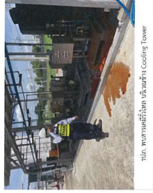
Local Operator ไปตรวจสอบที่จุดเกิดเหตุ พบโซเดียมไฮโปคลอไรท์รั่ว บริเวณาล์วท่อ Discharge ก่อนเข้า Cooling. Basin
