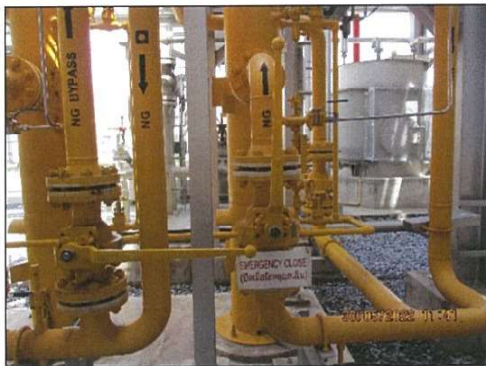
รูปที่ 2.2-36 อุปกรณ์ตัดระบบการลำเลียงก๊าซ
