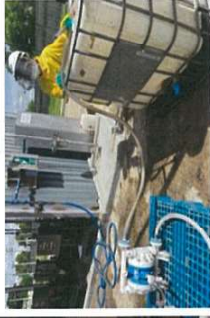
ทีมที่ 1 ค่อยๆ เดินน้ำลงใน Bund และจับน้ำโดยแพร่: ดูดน้ำไปโดยสารเคมีใน Bund ได้ทันที 1,000 ลิตร
