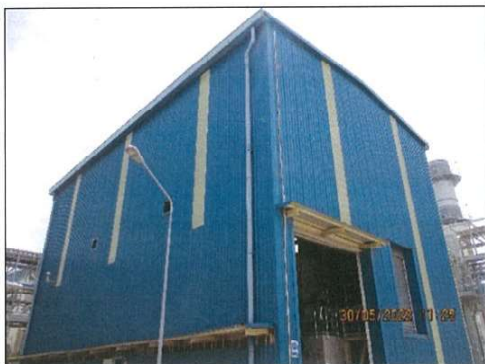
รูปที่ 2.2-8 อาคารครอบเครื่องจักรเพื่อป้องกันเสียง
