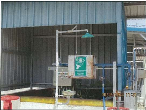
รูปที่ 2.2-31 อ่างล้างตาและฝักบัวชำระร่างกายฉุกเฉิน
