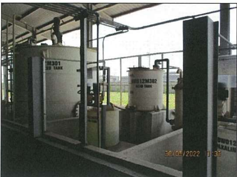
รูปที่ 2.2-13 ถังปรับสภาพน้ำ (Neutralization Tank)
