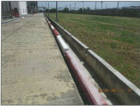
รูปที่ 2.2-11 รางระบาย/รวบรวมน้ำฝน
