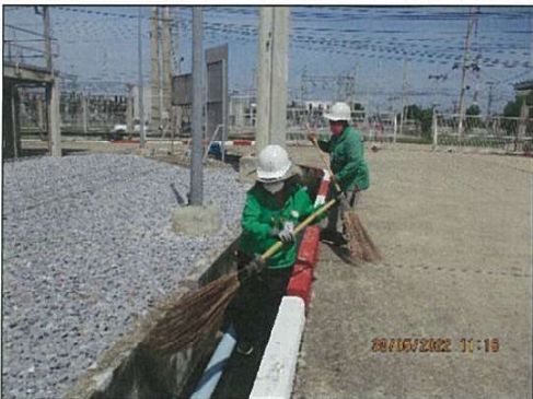
รูปที่ 2.2-12 การทำความสะอาดรางระบาย/รวบรวมน้ำฝน
