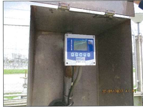
รูปที่ 2.2-15 เครื่องตรวจวัดคุณภาพน้ำแบบอัตโนมัติ
