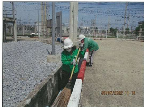
รูปที่ 2.2-12 การทำความสะอาดรางระบาย/รวบรวมน้ำฝน
