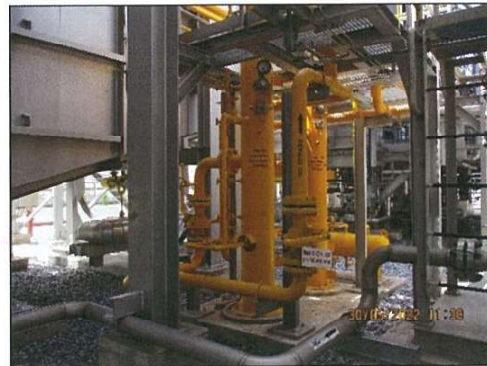
รูปที่ 2.2-36 อุปกรณ์ตัดระบบการลำเลียงก๊าซ
