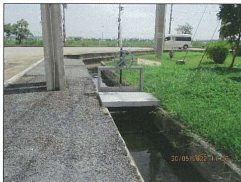
รูปที่ 2.2-14 Inspection Manhole ของโครงการกับสวนอุตสาหกรรมโรจนะ
