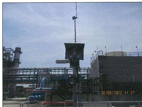
รูปที่ 2.2-37 Gas Detector บริเวณสถานีอัดก๊าซ
