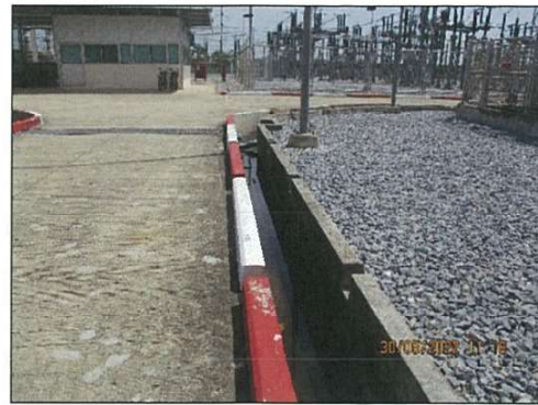
รูปที่ 2.2-11 รางระบาย/รวบรวมน้ำฝน
