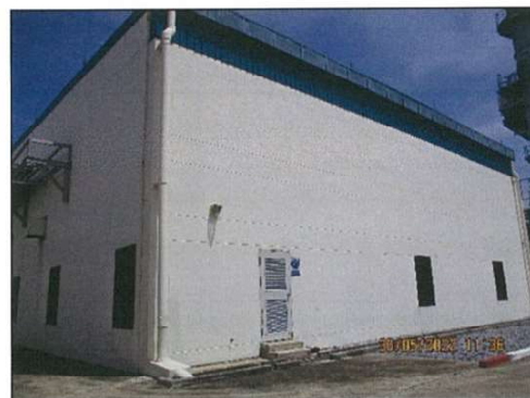
รูปที่ 2.2-8 อาคารครอบเครื่องจักรเพื่อป้องกันเสียง
