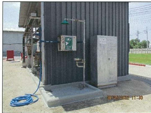
รูปที่ 2.2-31 อ่างล้างตาและฝักบัวชำระร่างกายฉุกเฉิน
