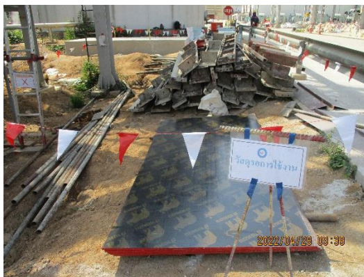
รูปที่ 2-15 พื้นที่จัดเก็บเศษวัสดุจากงานก่อสร้าง พร้อมติดป้ายระบุวัสดุรอกการขนย้าย
