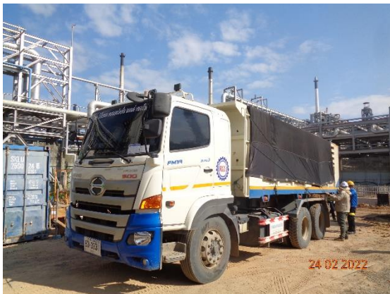
รูปที่ 2-5 การปิดคลุมรถขนส่งวัสดุอุปกรณ์
