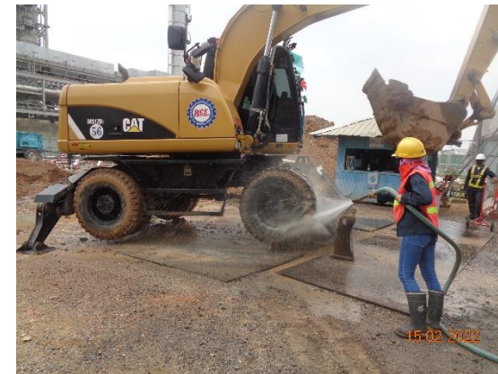
รูปที่ 2-6 การฉีดล้างล้อรถก่อนออกจากพื้นที่ก่อสร้าง
