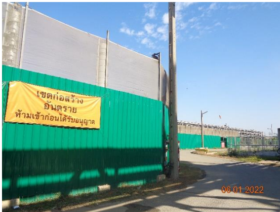
รูปที่ 2-3 แผงตาข่ายกันฝุ่นละอองรอบพื้นที่ก่อสร้าง
