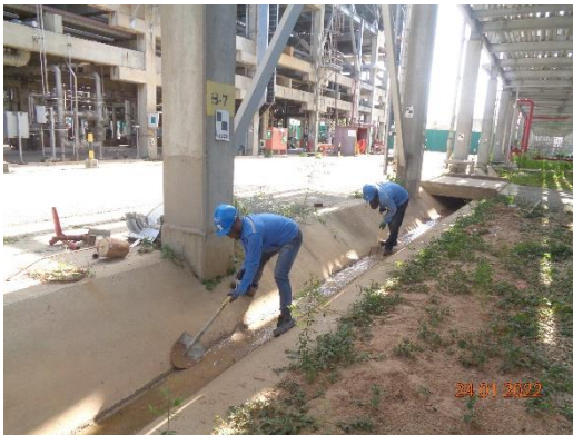
รูปที่ 2-25 การขุดลอกรางระบายน้ำ
