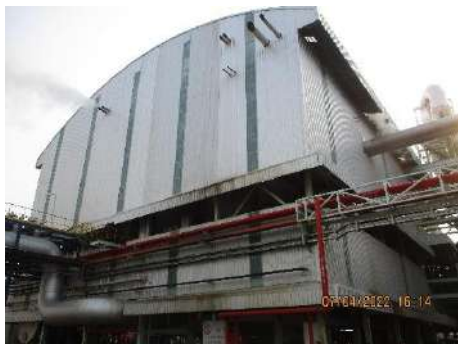
รูปที่ 81 การปิดครอบแหล่งกำเนิดที่มีเสียงดัง
