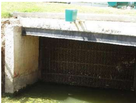
รูปที่ 31 บ่อสูบน้ำและตะแกรงดักเศษวัชพืชและป้องกันสัตว์น้ำ
