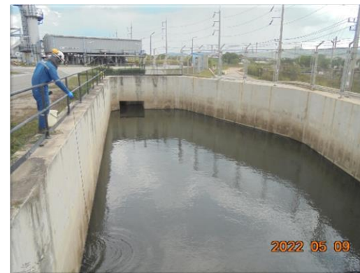
รูปที่ 2-18 บ่อพักน้ำฝนไม่ปนเปื้อน Sedimentation Basin
