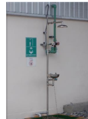
รูปที่ 2-28 ฝักบัวอาบน้ำ ล้างตาฉุกเฉิน
