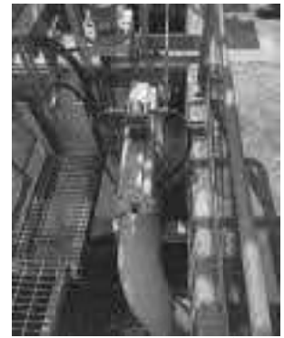
วาล์วควบคุมทิศทางการไหลของน้ำหล่อเย็น ไปยังบ่อกักน้ำหล่อเย็น และบ่อฉุกเฉิน
