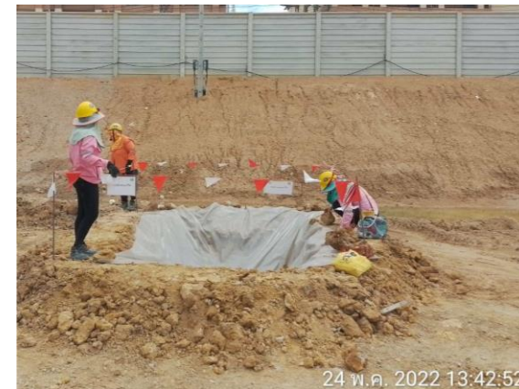
รูปที่ 2-10 บ่อล้างและรวบรวมตะกอนคอนกรีต
