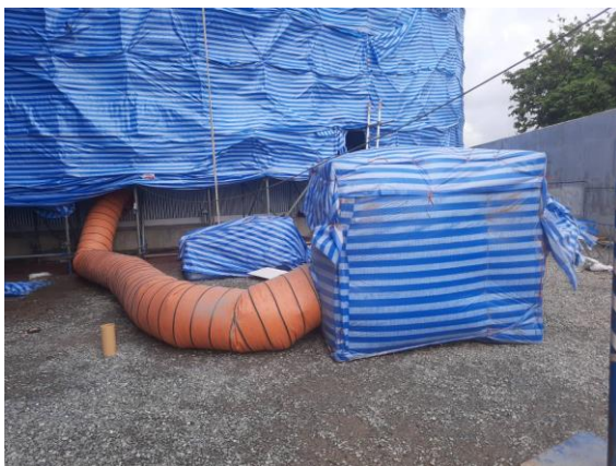
รูปที่ 2-3 การปิดคลุมด้วยผ้าใบเพื่อป้องกันการฟุ้งกระจายของ Copper slag
