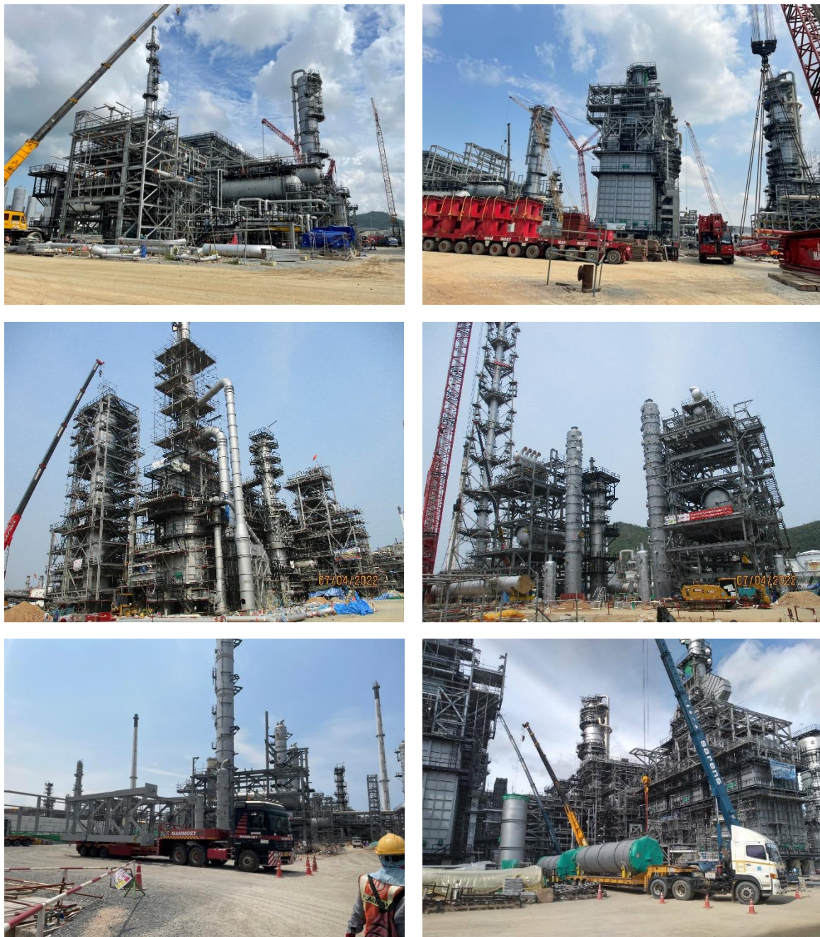
รูปที่ 1-3 (ต่อ) งานติดตั้งและขนย้ายโครงสร้างของอุปกรณ์ ชั้่งงาน
