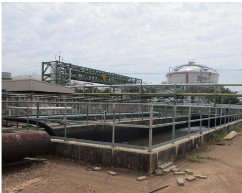
รูปที่ 3-31 บ่อพักน้ำ (Sump) ในพื้นที่รวบรวมกากของเสีย
