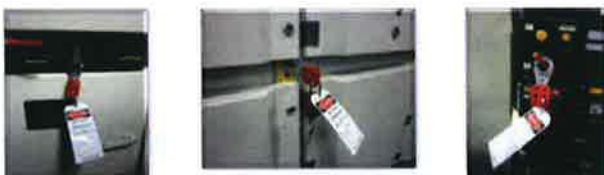
รูปแสดงการตัดแยกไฟฟ้าภายในอาคาร (Substation)
