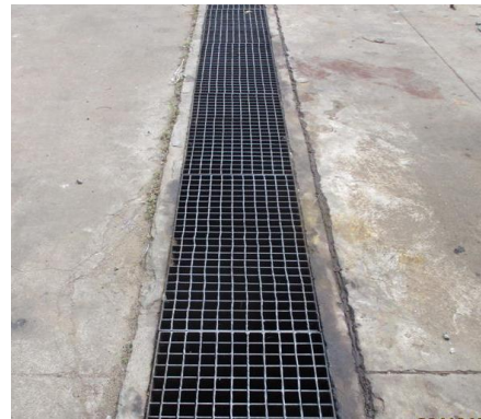
รูปที่ 3-30 รางระบายน้ำในพื้นที่รวบรวม กากของเสีย
