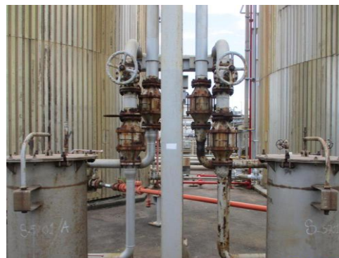
รูปที่ 3-7 Activated Carbon Canister
