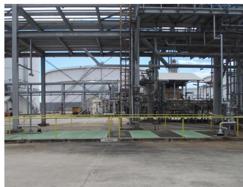
รูปที่ 3-18 บ่อพักสำหรับรองรับน้ำปนเปื้อนน้ำมัน (T-5418)
