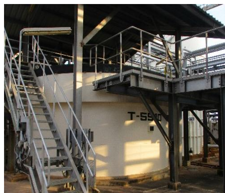
ระบบ Flocculation-Floatation (FFU)
