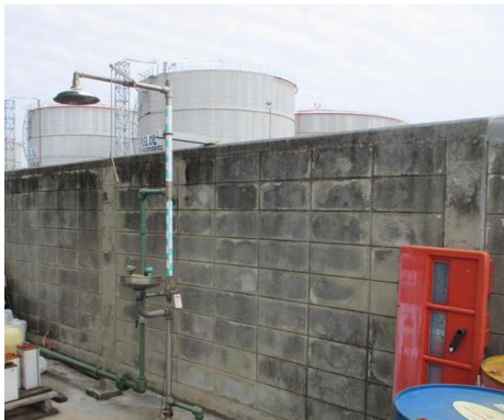
รูปที่ 3-29 อุปกรณ์ดับเพลิง และ Safety Shower & Eye Washer ในพื้นที่รวบรวมกากของเสีย
