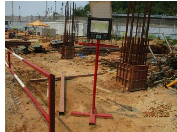
รูปที่ 2-36 ไฟฟ้าส่องสว่างฉุกเฉิน
