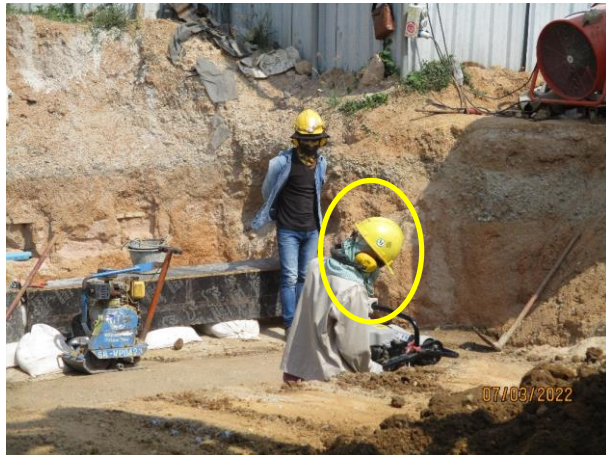
รูปที่ 2-32 การสวมใส่อุปกรณ์ลดเสียงและป้ายเตือนให้สวมใส่อุปกรณ์ลดเสียง
