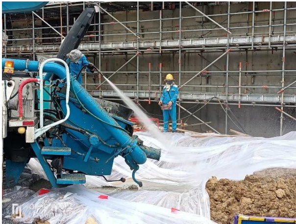
รูปที่ 2-10 การทำความสะอาดรางระบายคอนกรีตของรถขนคอนกรีต
