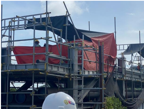
รูปที่ 2-4 การปิดคลุมด้วยผ้าใบทุกด้านเพื่อป้องกัน Copper slag ฝุ่นออกจากพื้นที่ปฏิบัติงาน
