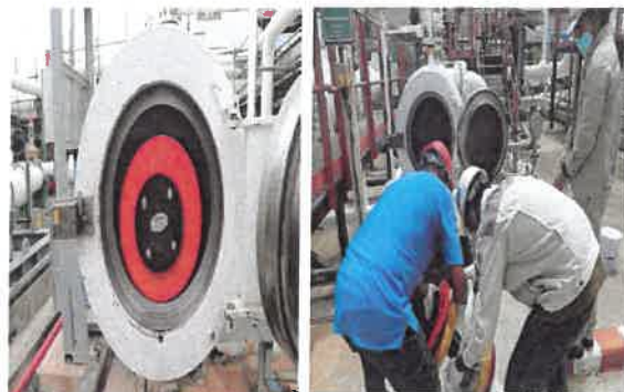
รูปที่ 2-16 การส่ง Cleaning Pig
