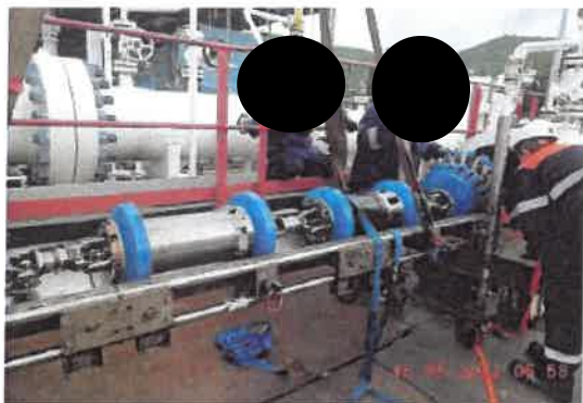
รูปที่ 2-15 การส่ง Intelligent Pig
