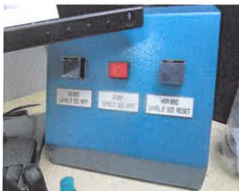
ระบบหยุดปั๊มอัตโนมัติ สถานีสูบน้ำมันมาบตาพุด
