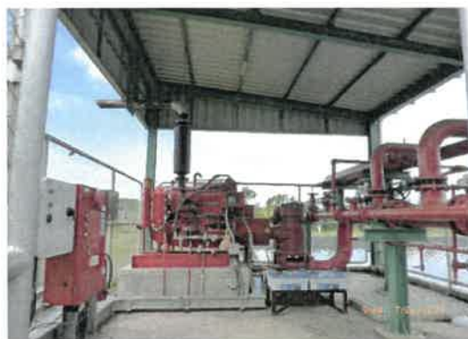
รูปที่ 2-20 ระบบป้อนดับเพลิง บริเวณสถานีควบคุมระบบท่อที่ 652
