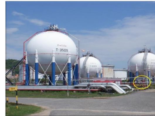
รูปที่ 2-29 วาล์วปิดทางออกฉุกเฉินสำหรับถังเก็บกักปิโตรเลียมเหลว
