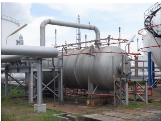
รูปที่ 2-30 ระบบควบคุมการสูบกลับกรณีเกิดการรั่วไหล
