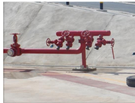
รูปที่ 2-41 หัวฉีดน้ำดับเพลิงชนิดประจำพื้นที่ (Deluge valve system)
