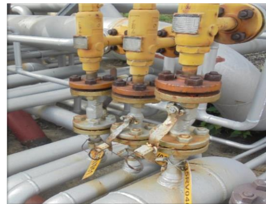
รูปที่ 2-35 Lock-out Mercaptan Injection Pump
