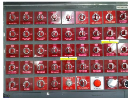
รูปที่ 2-33 ระบบหยุดสุบถ่ายฉุกเฉินทั้งระบบ บริเวณห้องควบคุม
