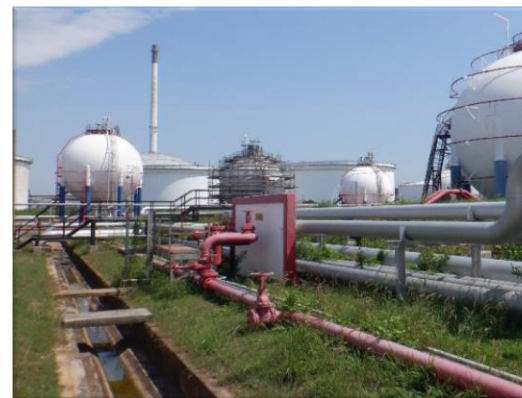
รูปที่ 2-39 วาล์วน้ำหล่อเย็นแบบเปิดด้วยมือ (Manual valve)
