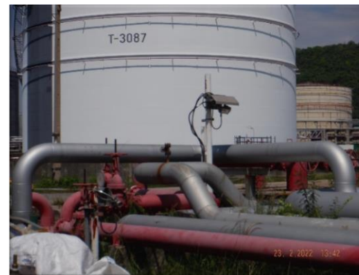
รูปที่ 2-23 อุปกรณ์ตรวจจับสารไวไฟรั่วระเหยแบบลำแสง
