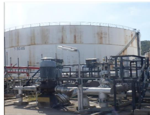
รูปที่ 2-31 ระบบปั๊มสุบถ่ายความดันสูง
