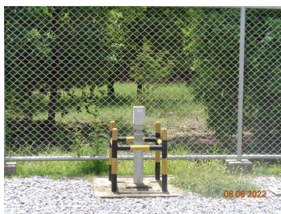
รูปที่ 3-10 ระบบจ่ายกระแสไฟฟ้า Rectifier
