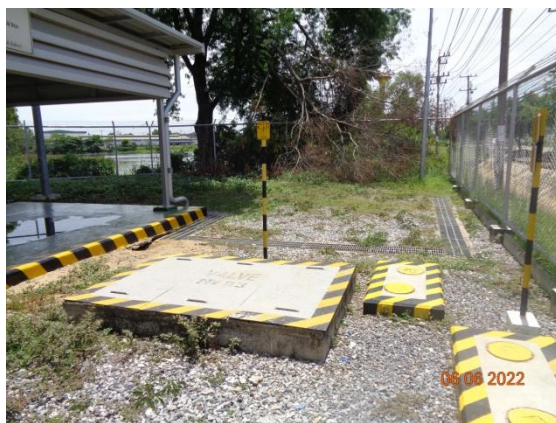
รูปที่ 3-6 อุปกรณ์ดับเพลิง และวาล์วควบคุม ประจำสถานีก๊าซ
