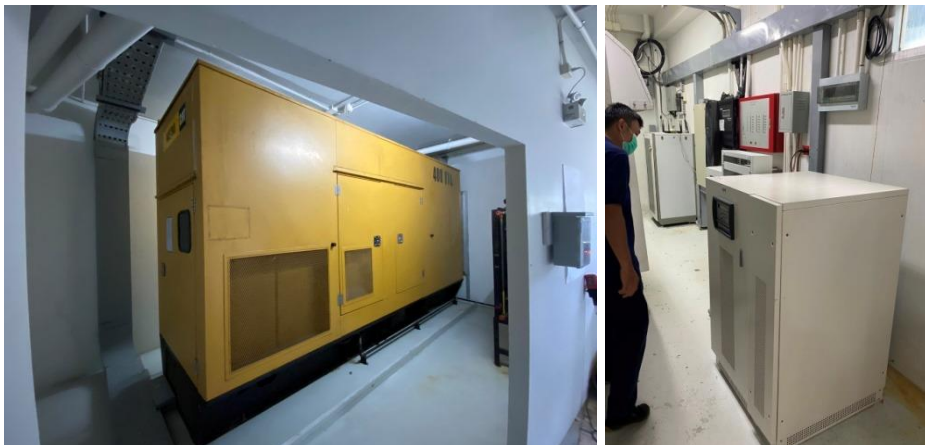
(ภาพที่ 17) เครื่อง Generator และเครื่องสำรองไฟ (UPS)
