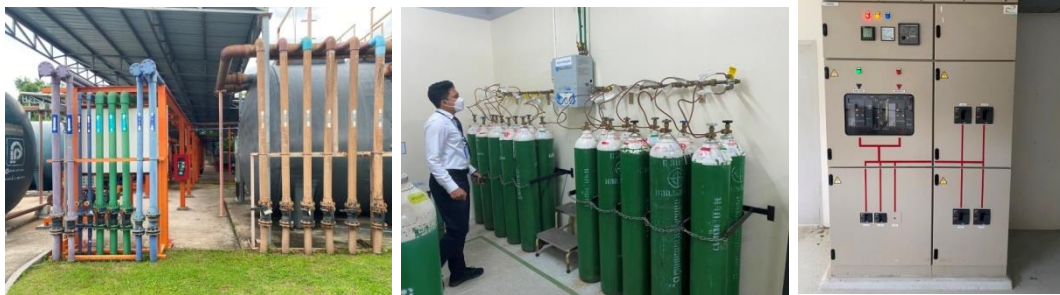
(ภาพที่ 5) ป้ายแสดงตำแหน่งของวาล์วปิดน้ำ วาล์วปิดก๊าซ สะพานไฟฟ้า
