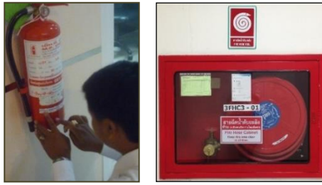
รูปที่ 21 การตรวจสอบอุปกรณ์ดับเพลิงในโรงพยาบาล
