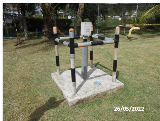
รูปที่ 3-2 ระบบวาล์วใต้ดินเพื่อสามารถตัดแยกกระบบกรณีเกิดเหตุฉุกเฉิน
