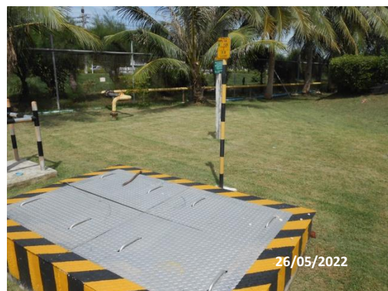
รูปที่ 3-2 ระบบวาล์วใต้ดินเพื่อสามารถตัดแยกกระบบกรณีเกิดเหตุฉุกเฉิน
