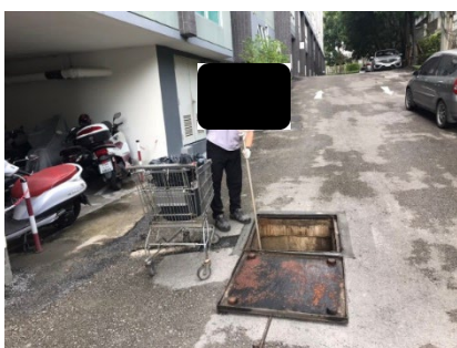
ภาพที่ 2.2-12 (ต่อ) การสูบน้ำตกตะกอน ตักตะกอน ไขมัน
