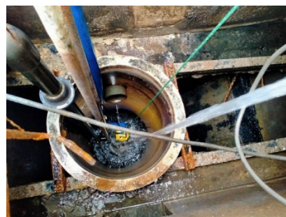
ภาพที่ 2.2-12 การสูบลากตะกอน ตักตะกอน ไขมัน
