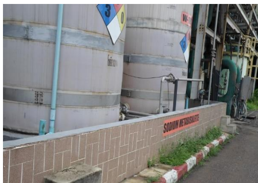
รูปที่ 29 คันคอนกรีตรอบถังเก็บวัตถุดิบและเคมีภัณฑ์
