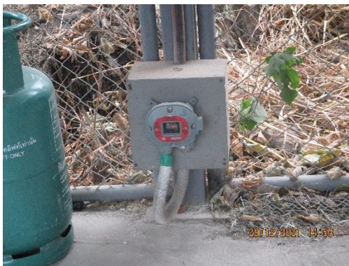
รูปที่ 28 การติดตั้งระบบตรวจวัดก๊าซ (Monomer Gas Detector)
