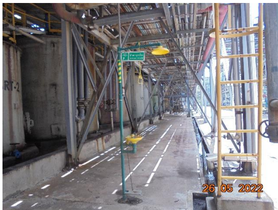
รูปที่ 24 การติดตั้งฝักบัวอาบน้ำและที่ล้างตาฉุกเฉิน
