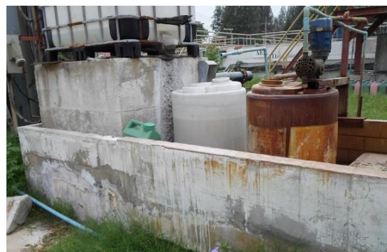
รูปที่ 29 คันคอนกรีตรอบถังเก็บวัตถุดิบและเคมีภัณฑ์
