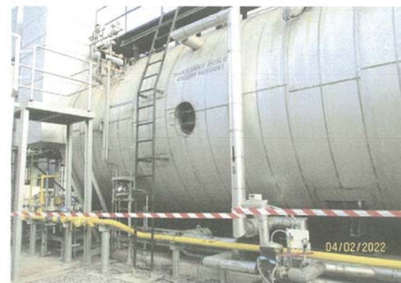
ตรวจสอบอุปกรณ์ภายนอกของหม้อไอน้ำ หม้อไอน้ำหมายเลข Aux Boiler ( 00QHB10BB001) บริษัท ราชบุรีเวิลด์ โคเจนเนอเรชั่น จำกัด. วันที่ 4 กุมภาพันธ์ 2565
