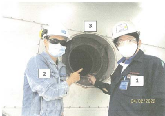
หมายเลข 1 วิศวกรผู้ตรวจทดสอบ หมายเลข 2 ผู้ควบคุมหม้อไอน้ำ หมายเลข3 ท่อน้ำภายในหม้อไอน้ำ หม้อไอน้ำหมายเลข Aux Boiler ( 00QHB10BB001) บริษัท ราชบุรีเวิลด์ โคเจนเนอเรชั่น จำกัด. วันที่ 4 กุมภาพันธ์ 2565
