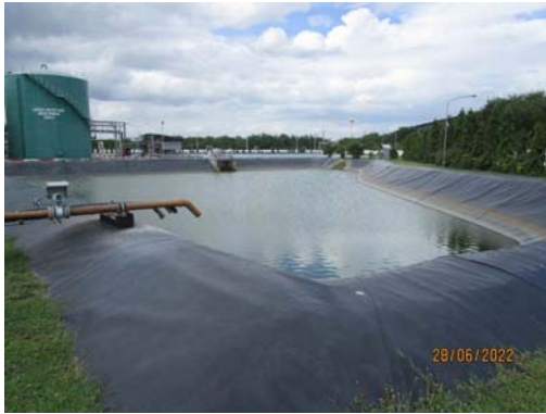
รูปที่ 6 บ่อพักน้ำทั้งหมดขนาด 5,000 ลูกบาศก์เมตร
