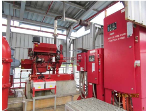
รูปที่ 37 ระบบปั้มน้ำดับเพลิง
