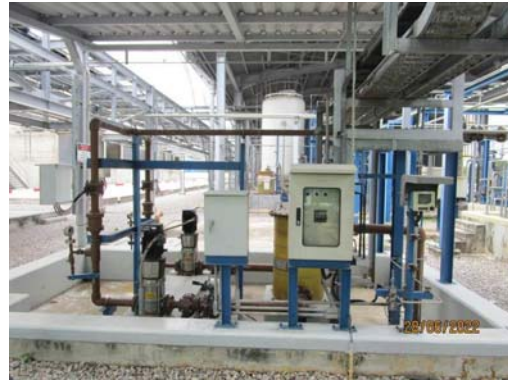
รูปที่ 7 บ่อปรับสภาพน้ำปนเปื้อนสารเคมีด้วยกรด-ด่าง
