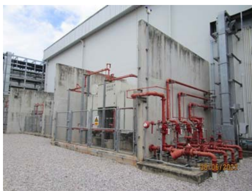
รูปที่ 29 ระบบฉีดพ่นน้ำ
