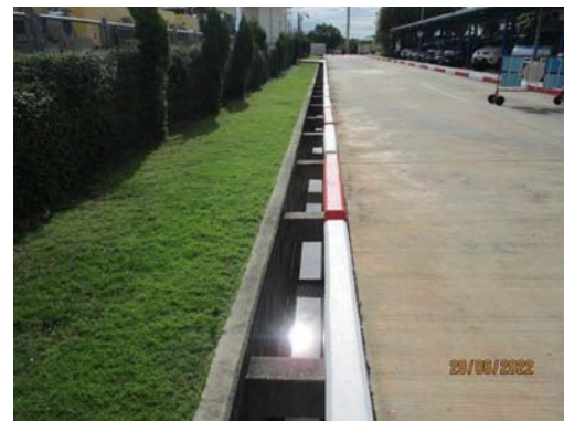
รูปที่ 3 รางระบายน้ำฝนที่ตกในพื้นที่ทั่วไป
