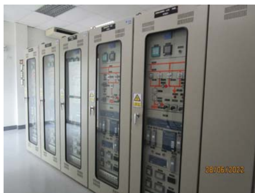
รูปที่ 50 ระบบป้องกันทางไฟฟ้า (Relay) หม้อแปลงไฟฟ้า
