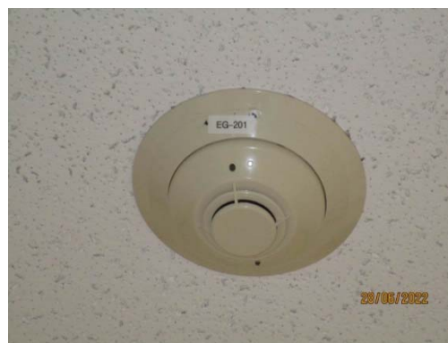
รูปที่ 28 ระบบตรวจจับควัน
