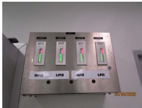
รูปที่ 46 มาตรวัดระดับน้ำและระบบสัญญาณเตือน
