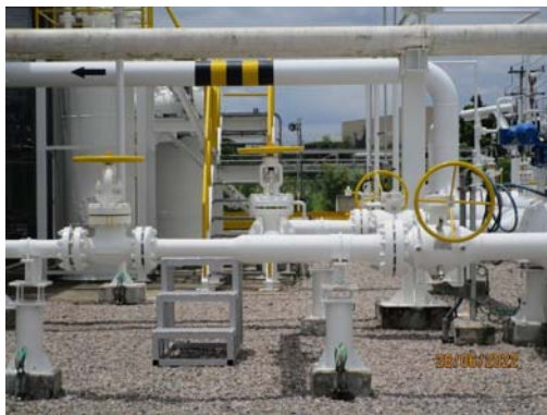
รูปที่ 53 ระบบท่อ Bypass และระบบวาล์วสำรอง
