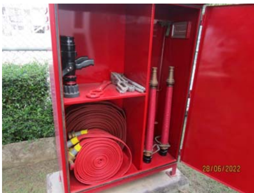
รูปที่ 35 ตู้เก็บอุปกรณ์สำหรับดับเพลิง
