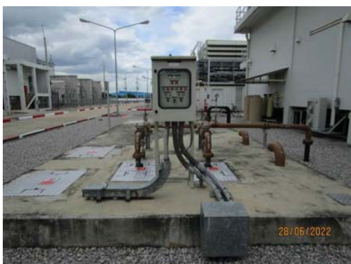
รูปที่ 4 บ่อแยกน้ำ-น้ำมัน (Oil/ Water Separator)
