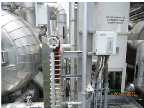
รูปที่ 46 มาตรวัดระดับน้ำและระบบสัญญาณเตือน
