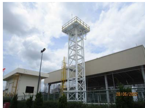
รูปที่ 54 ปล่องระบายก๊าซ (Blow down stack)
