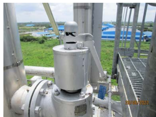
รูปที่ 45 Safety Valve ที่ท่อ steam ของหม้อไอน้ำ
