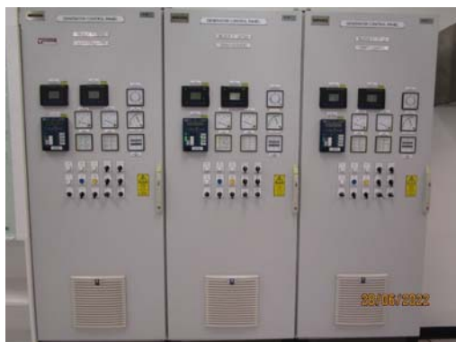
รูปที่ 49 ระบบป้องกันทางไฟฟ้า (Relay) ที่เครื่องกำเนิดไฟฟ้า
