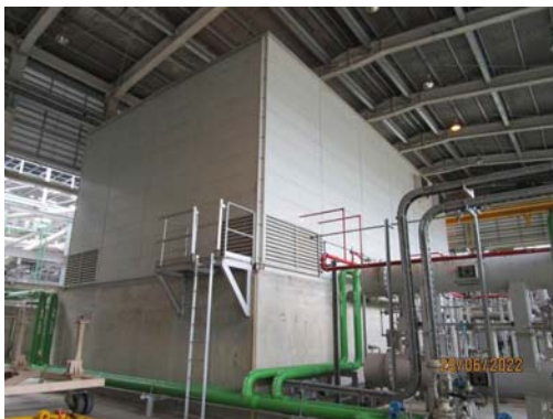
รูปที่ 13 อาคารปิดครอบเครื่องจักรที่มีเสียงดัง
