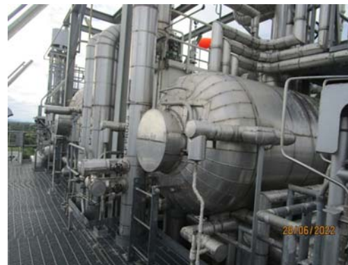
รูปที่ 48 ฉนวนหุ้มเปลือกหม้อไอน้ำและท่อที่ร้อน
