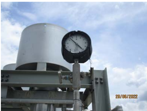
รูปที่ 47 มาตรวัดความดันไอน้ำที่หม้อไอน้ำ
