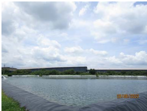
รูปที่ 8 บ่อน้ำดิบขนาด 35,000 ลูกบาศก์เมตร
