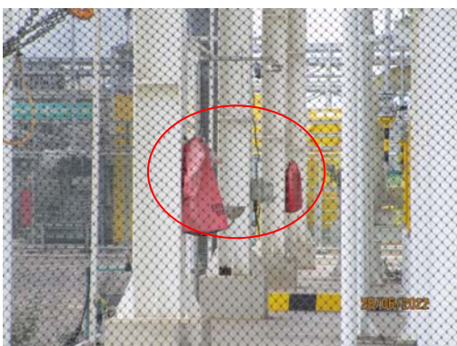
รูปที่ 55 เครื่องดับเพลิงชนิดผง (Powder Extinguisher)
