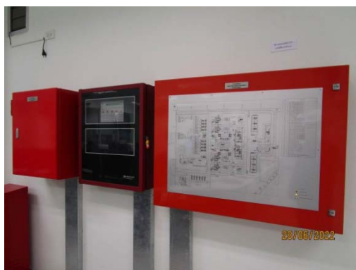
รูปที่ 27 ระบบสัญญาณเตือนภัย (Fire alarm)
