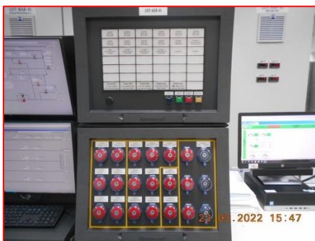
ภาพที่ 2.2-29 Distributed Control System (DCS) สำหรับควบคุมการทำงานของระบบ
