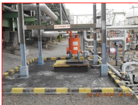
ภาพที่ 2.2-21 Slop Oil Tank รวบรวมเศษน้ำมันจากหน่วย CPI
