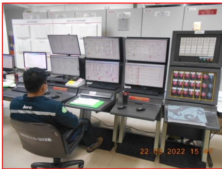
ภาพที่ 2.2-29 Distributed Control System (DCS) สำหรับควบคุมการทำงานของระบบ
