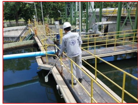
ภาพที่ 2.2-8 ระบบบำบัดแบบ Activated Sludge และ Receiving Pond
