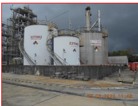
ภาพที่ 2.2-33 Band Wall ป้องกัน Tank pit
