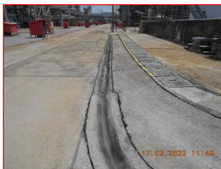
ภาพที่ 2.2-6 รางระบายน้ำฝนโดยรอบโครงการ
