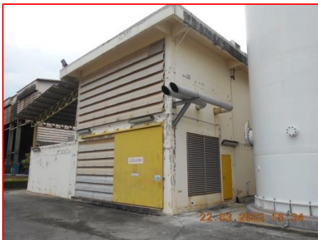
ภาพที่ 2.2-11 การติดตั้งอุปกรณ์ที่ทำให้เกิด เสียงดังในห้องปิด
