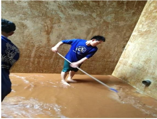
เจ้าหน้าที่ล้างถังเก็บน้ำสำรอง ภาพที่ 2.2-4 (ต่อ) ระบบน้ำใช้
