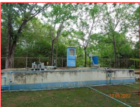
ภาพที่ 2-13 ระบบบำบัดน้ำเสีย แบบตะกอนเร่ง (AS)
