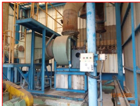
ภาพที่ 2-2 Lamellar Mist Separator
