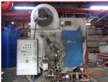
ภาพที่ 2-1 ระบบควบคุมแก๊สอัตโนมัติ เพื่อควบคุมส่วนผสมระหว่างอากาศและน้ำมันที่ Boiler
