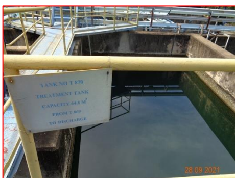
ภาพที่ 2-5 บ่อพักน้ำทิ้ง ที่ผ่านการบำบัดแล้ว (T-870)
