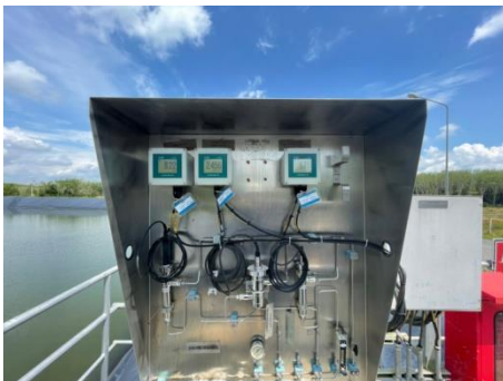
รูปที่ 2-30 การตรวจวัดคุณภาพน้ำทิ้งแบบออนไลน์
