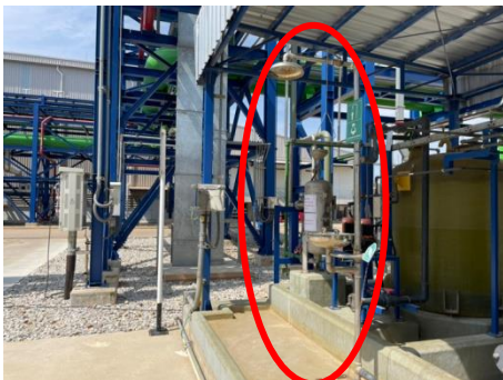
รูปที่ 2-68 อ่างล้างตาฉุกเฉิน และชำระล้างฉุกเฉิน
