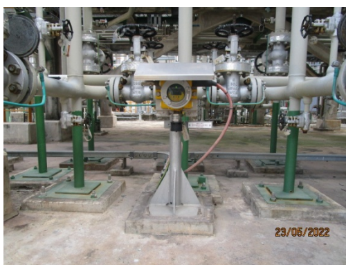
รูปที่ 3-14 Gas Detector
