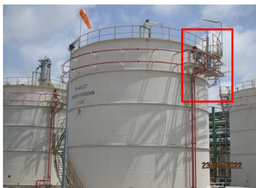
รูปที่ 3-66 ระบบโคมของถังเก็บกักสารเคมี
