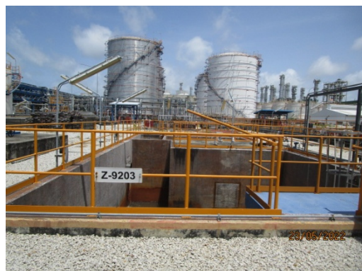
รูปที่ 3-28 บ่อรับน้ำทิ้งจากระบบ
