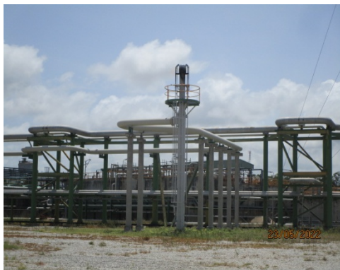
รูปที่ 3-7 หอเผาแบบความดันต่ำ (Low Pressure Flare)
