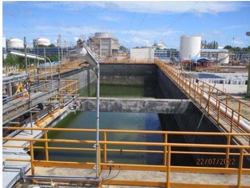
รูปที่ 3-29 บ่อพักน้ำทิ้งฉุกเฉิน (Diversion Basin : TK-9142A/B)
