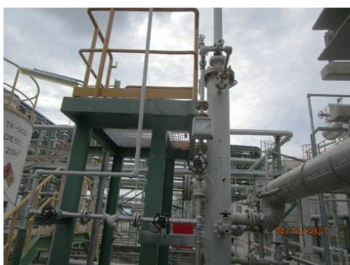
รูปที่ 3-13 อุปกรณ์ตรวจวัดอัตราการไหล ของน้ำที่เข้าสู่ Scrubber
