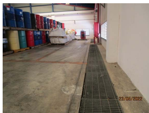
รูปที่ 3-54 รางระบายน้ำในอาคารเก็บของเสีย
