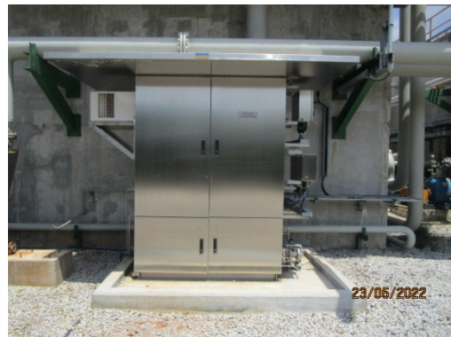
รูปที่ 3-32 เครื่องตรวจวัด COD แบบอัตโนมัติ ที่ Final Polishing Buffer Tank (TK-9145)
