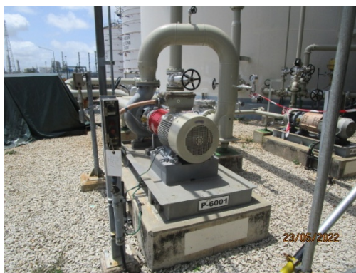
รูปที่ 3-12 เครื่องสูบน้ำสำรอง สำหรับระบบน้ำที่จ่ายน้ำให้ Scrubber
