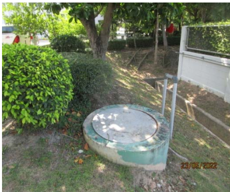
รูปที่ 3-37 บ่อตรวจสอบคุณภาพน้ำทิ้ง จากสำนักงานและโรงอาหาร
