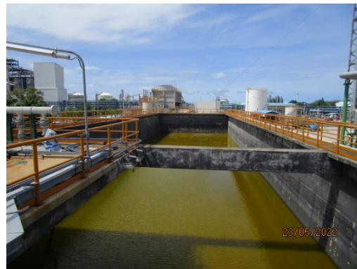
ระบบบำบัดน้ำเสียทางชีวภาพ แบบเติมอากาศแบบต่อเนื่อง
