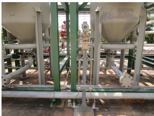
รูปที่ 3-9 เครื่องตรวจวัดความดันที่ทางเข้า-ออกของ Charcoal Adsorber
