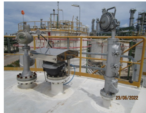
รูปที่ 3-71 Pressure/Vacuum Vent Valve
