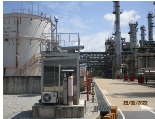
รูปที่ 3-69 Open Path Gas Detection
