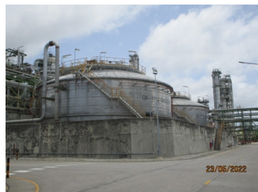
รูปที่ 3-67 คันคอนกรีตบริเวณที่เก็บกักวัตถุอันตรายและผลิตภัณฑ์
