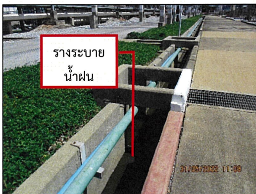
ภาพถ่ายที่ 2.2-17 วางระบายรวบรวมน้ำฝน ท่อระบายน้ำเสีย
