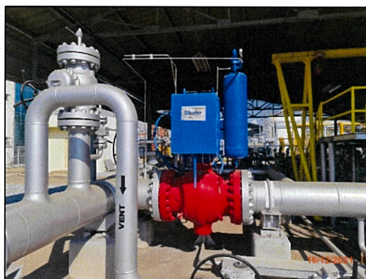
ภาพถ่ายที่ 2.2-38 อุปกรณ์ตัดระบบการลำเลียงก๊าซกรณีฉุกเฉิน
