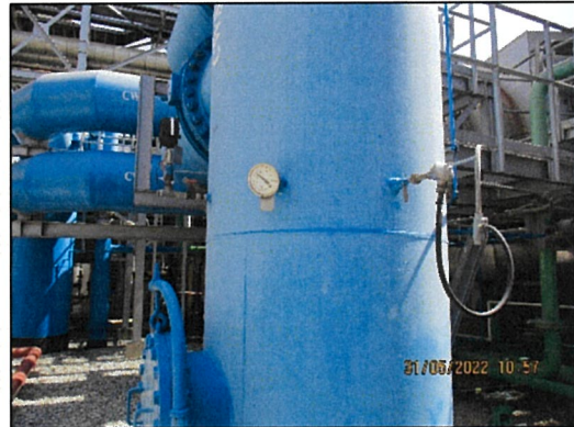
ภาพถ่ายที่ 2.2-11 เครื่องวัดอุณหภูมิน้ำของหอหล่อเย็น
