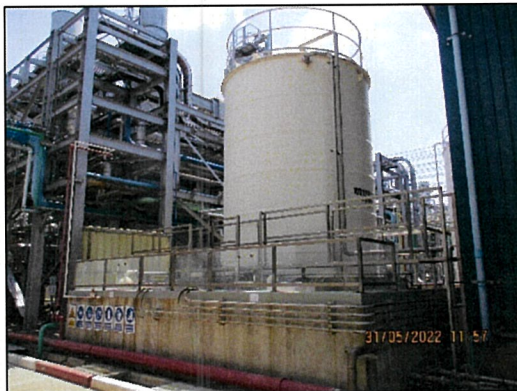
ภาพถ่ายที่ 2.2-9 ถังปรับสภาพน้ำ (Neutralization tank)
