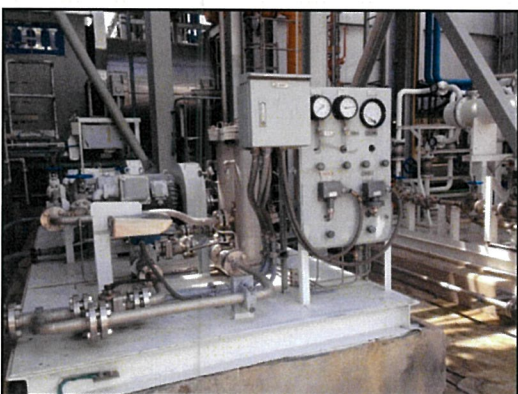
De-NO x Water System HRSG#3
