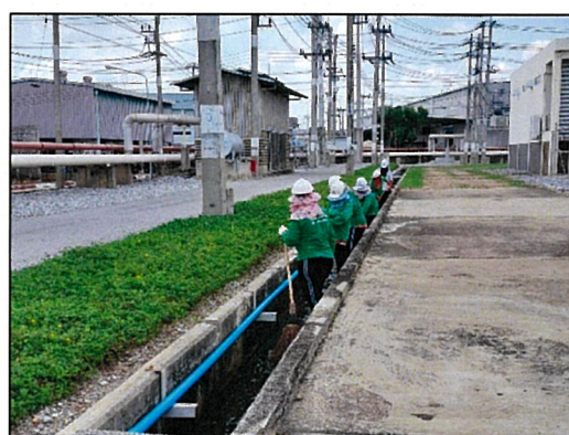
ภาพถ่ายที่ 2.2-19 การทำความสะอาดรางระบายน้ำฝน
