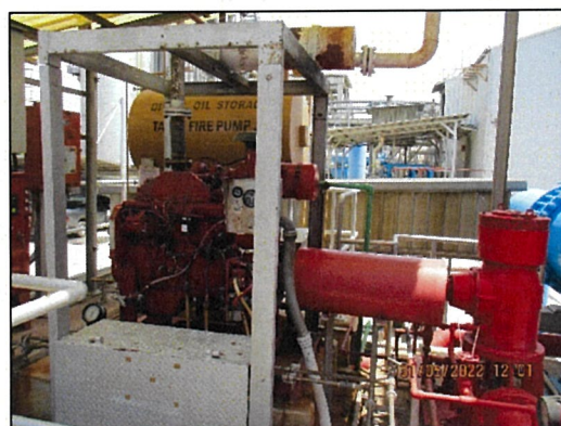
ภาพถ่ายที่ 2.2-35 ป้อนน้ำดับเพลิงของโครงการ
