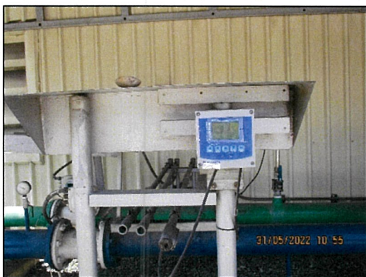
ภาพถ่ายที่ 2.2-13 เครื่องตรวจวัดค่า pH, Temp, Conduct แบบอัตโนมัติ
