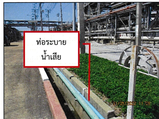
ภาพถ่ายที่ 2.2-17 วางระบายรวบรวมน้ำฝน ท่อระบายน้ำเสีย
