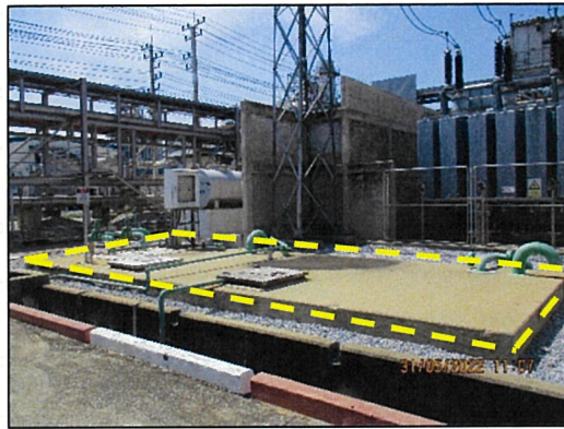
ภาพถ่ายที่ 2.2-10 ถังแยกน้ำและน้ำมัน (Oil Separator)
