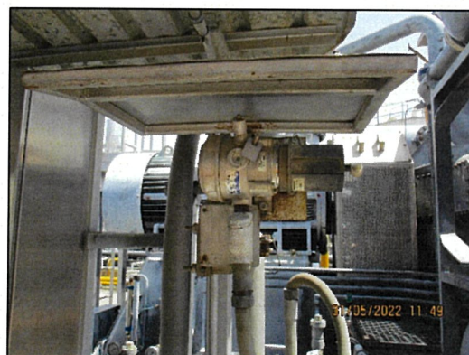
ภาพถ่ายที่ 2.2-24 สายล่อฟ้า สายดิน และ Gas Detector
