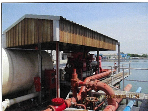
ภาพถ่ายที่ 2.2-35 ป้อนน้ำดับเพลิงของโครงการ
