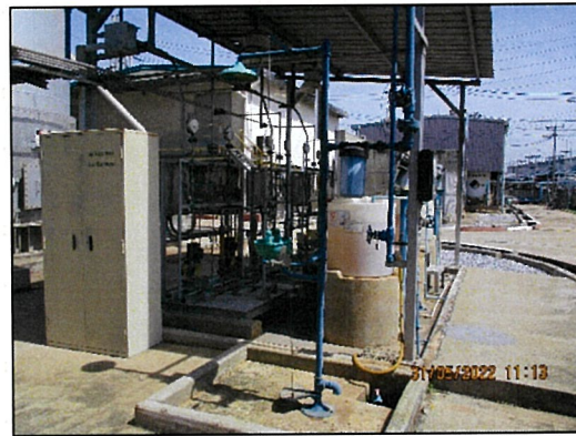
ภาพถ่ายที่ 2.2-25 อุปกรณ์ชำระล้างฉุกเฉิน (Emergency Shower and Eye Wash Fountain)
