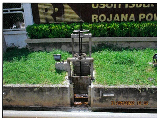
ภาพถ่ายที่ 2.2-18 ประตูกันน้ำที่จุดเชื่อมต่อระหว่างรางรวบรวมน้ำฝนภายในโครงการและ รางรวบรวมน้ำฝนของสวนอุตสาหกรรม
