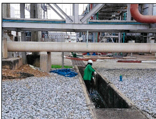
ภาพถ่ายที่ 2.2-19 การทำความสะอาดรางระบายน้ำฝน
