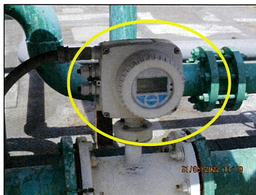
ภาพถ่ายที่ 2.2-13 เครื่องตรวจวัดค่า pH, Temp, Conduct แบบอัตโนมัติ
