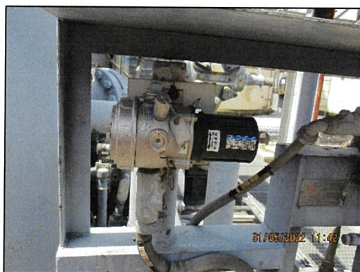
ภาพถ่ายที่ 2.2-24 สายล่อฟ้า สายดิน และ Gas Detector
