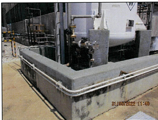
ภาพถ่ายที่ 2.2-32 เขื่อนคอนกรีต (Bund wall)
