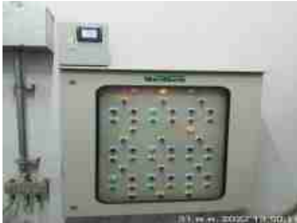
รูปที่ 2-13 ติดตั้งมาตรวัดไฟฟ้าในส่วนของระบบบำบัดน้ำเสีย แยกออกจากส่วนอื่นๆ
