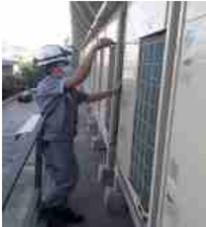
รูปที่ 2-50 ทำความสะอาดแผงกรองอากาศเครื่องส่งลมเย็น
