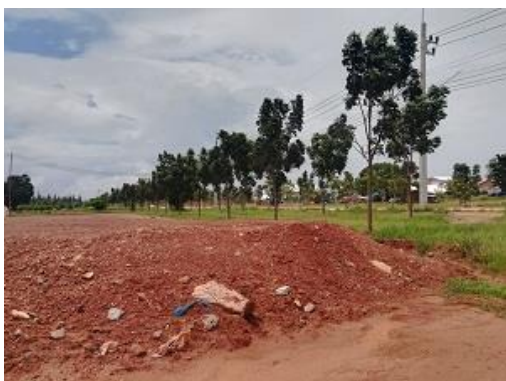
รูปที่ 2-11 ดินที่ได้จากขุดบ่อกักเก็บน้ำมาใช้ปรับพื้นที่ ในการก่อสร้าง
