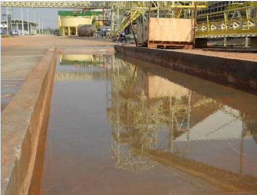
รูปที่ 2-27 ระบบการทำความสะอาดล้อรถบรรทุกที่ ออกจากพื้นที่โครงการ และพื้นที่ก่อสร้าง
