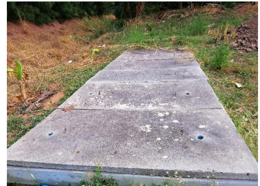
รูปที่ 2-10 บ่อดักไขมันของอาคารต่างๆ ก่อนปล่อย น้ำลงสู่แหล่งน้ำในพื้นที่โครงการ
