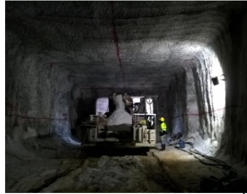
รูปที่ 2-62 การก่อสร้างช่องแผงเก็บทางแร่ในชั้น เกลือหิน (Backfill Panel)
