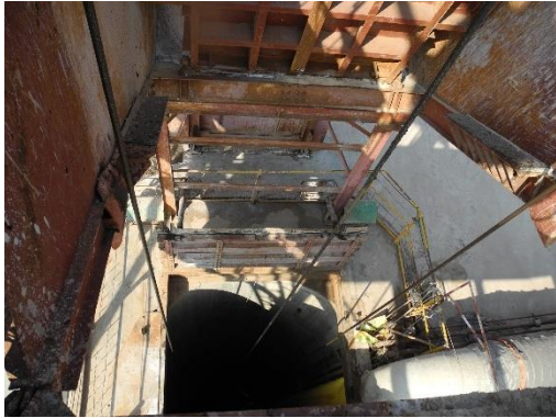
รูปที่ 2-61 ใช้เทคโนโลยีแบบ Hydraulic Breaker ในการเจาะอุโมงค์แนวตั้ง
