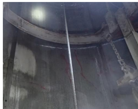
รูปที่ 2-60 คอนกรีตเสริมเหล็กเพื่อเสริมความ มั่นคงของผนังอุโมงค์แนวตั้ง
