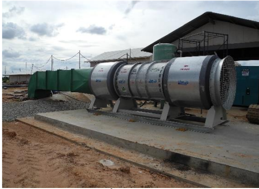
รูปที่ 2-67 ติดตั้งพัดลมอัดอากาศบริเวณปากทางเข้าของอุโมงค์แนวลาด
