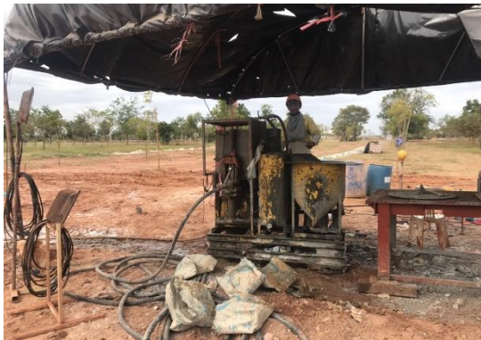
รูปที่ 2-63 เจาะหลุมที่ด้านข้างแนวอุโมงค์แนว เอียงตามระยะที่กำหนดในมาตรการ และทำการอัด ฉีดซีเมนต์จากพื้นดินลงไปเพื่อปิดผนึกชั้นน้ำใต้ดิน (Surface Grouting)
