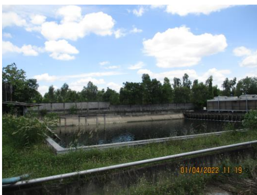
รูปที่ 8 ปอดักน้ำสุดท้าย ขนาด 9,000 ลบ.ม. (ปอดักน้ำดาดคอนกรีต)
