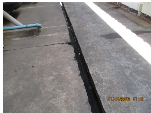
รูปที่ 17 รางรวบรวมน้ำฝน
