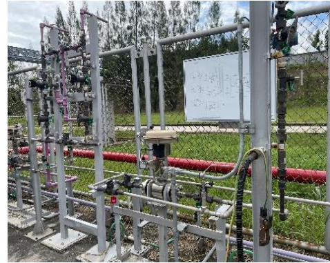
รูปที่ 3-64 อุปกรณ์ป้องกันก๊าซไหลกลับในท่อ (Check Valve)
