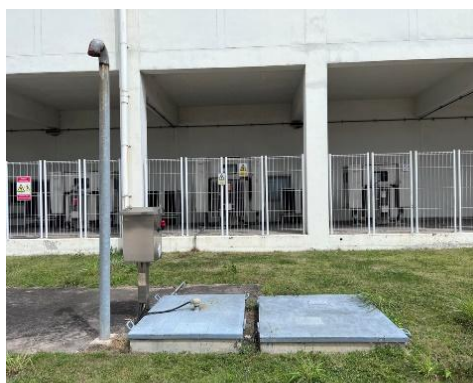
รูปที่ 3-11 ถังบำบัดน้ำเสียสำเร็จรูป
