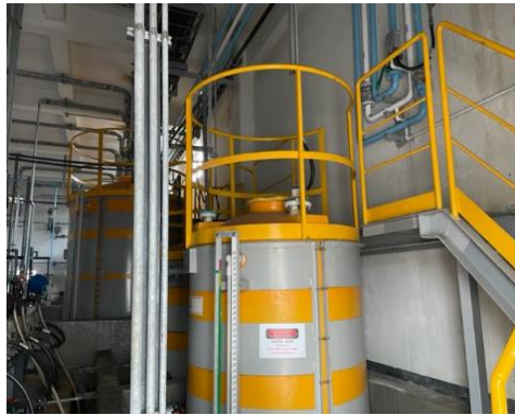
รูปที่ 3-57 การออกแบบให้หน่วยที่มี การใช้สารเคมีเป็นระบบปิด
