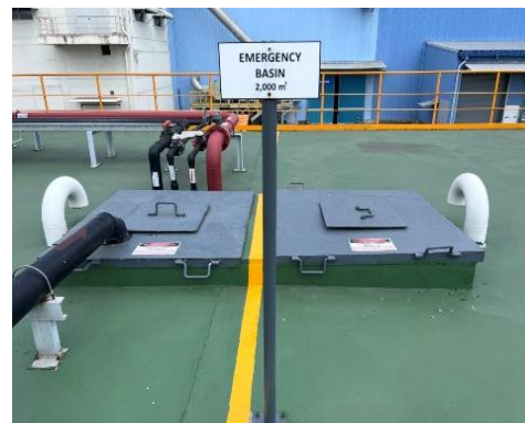
รูปที่ 3-10 บ่อพักน้ำทิ้งฉุกเฉิน
