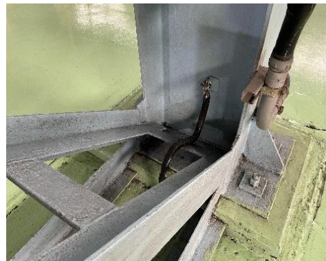
รูปที่ 3-36 อุปกรณ์ป้องกันกระแสไฟฟ้ารั่ว และระบบสายดิน
