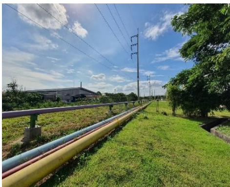
รูปที่ 3-17 ท่อระบายน้ำเสียและรางระบายน้ำฝนของโครงการ
