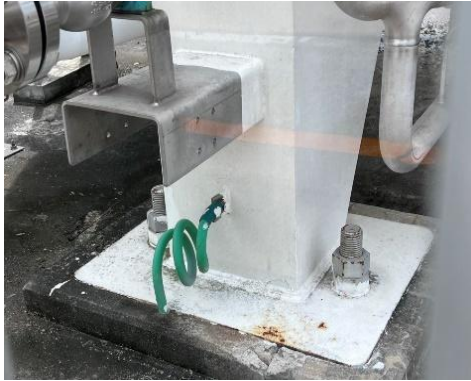
รูปที่ 3-63 อุปกรณ์กักเก็บและลำเลียง ต่อเข้ากับระบบสายดิน
