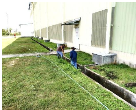
รูปที่ 3-19 การขุดลอกรางระบายน้ำ
