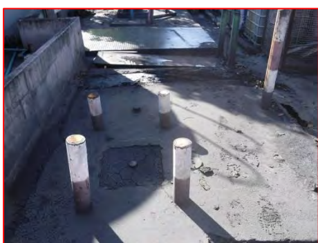
ภาพที่ 2.2-10 บ่อ Sump หรือบ่อพักน้ำปนเปื้อนที่ติดตั้งเครื่องสูบน้ำยังเตาเผาขยะ
