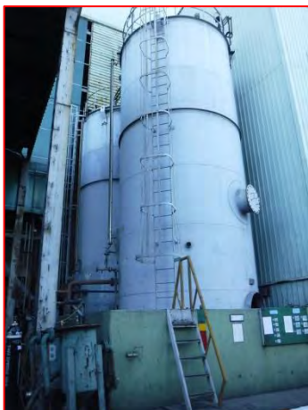
ภาพที่ 2.2-21 ถังเก็บของเสียประเภท ตะกอนที่สูบได้
