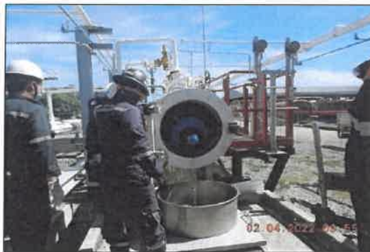
รูปที่ 2-3 การส่ง Intelligent Pig เพื่อตรวจสอบการรั่วของท่อส่งน้ำมัน
