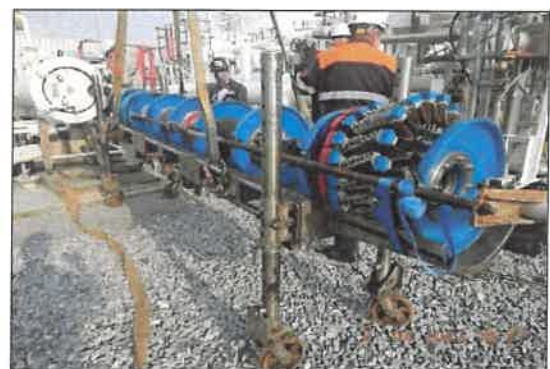
รูปที่ 2-3 การส่ง Intelligent Pig เพื่อตรวจสอบการรั่วของท่อส่งน้ำมัน
