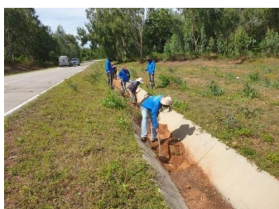
รูปที่ ค-3 โรงไฟฟ้าลำตะคองชลภาวัฒนาดำเนินการตรวจสอบสภาพรางระบายน้ำและแนวถนนตามแผนบำรุงรักษาโยธาเป็นประจำทุก 3 เดือน โดยสำรวจเมื่อเดือนมิถุนายน 2565 พบว่า สภาพถนนไหล่ทาง และรางระบายน้ำสภาพยังใช้งานได้ตามปกติ
