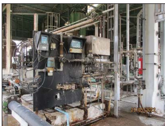
รูปที่ 2-13 ระบบปรับสภาพความเป็นกรด-ด่าง (Neutralization Pit)
