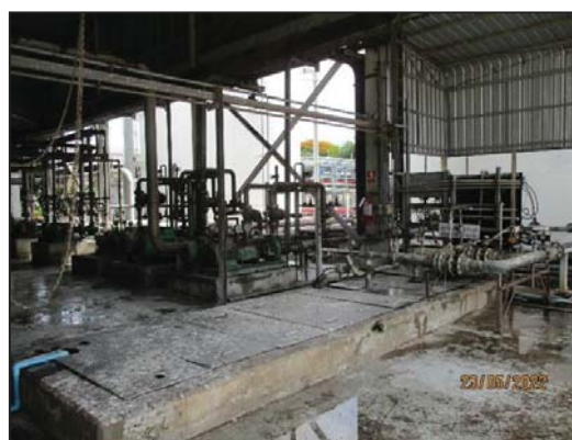
รูปที่ 2-13 ระบบปรับสภาพความเป็นกรด-ด่าง (Neutralization Pit)
