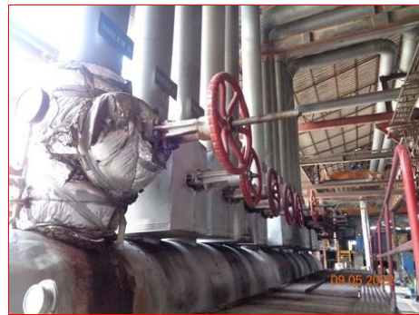
ภาพที่ 2.2-62 วาล์วควบคุม (Control valve) บริเวณกังหันไอน้ำ
