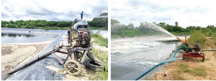
ภาพหลังการแก้ไขฟองขึ้นที่บ่อหมักไร้อากาศ (Anaerobic Pond 3,4,5)
