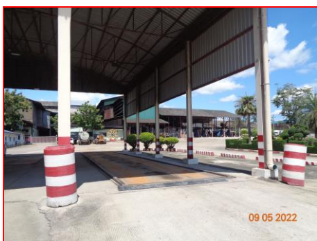
ภาพที่ 2.2-17 ตาชั่งน้ำหนักรถบรรทุก
