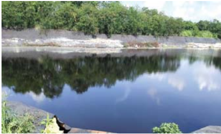
แสดงภาพหลังการแก้ไขฟองขึ้นที่บ่อหมักไร้อากาศ (Anaerobic Pond 1) ( ภาพถ่ายเมื่อวันที่ 2 มิ.ย.65 )
