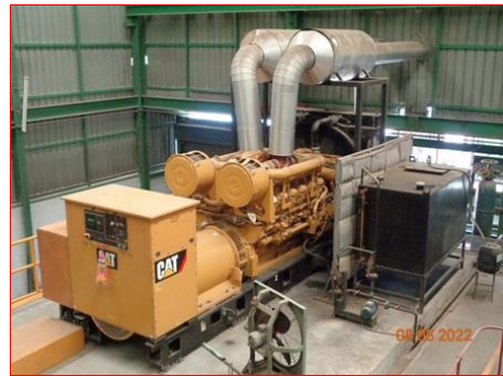
ภาพที่ 2.2-55 เครื่องกำเนิดไฟฟ้าสำรอง
