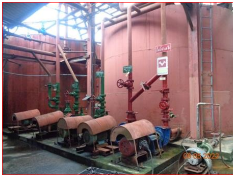
ภาพที่ 2.2-54 ป้อนน้ำดับเพลิง
