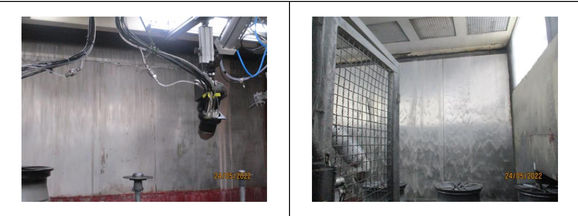
รูปที่ 8 ระบบม่านน้ำของกระบวนการพ่นสี
