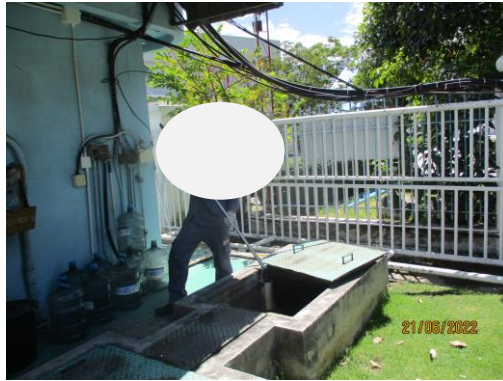
จุดปล่อยน้ำทิ้งของโรงงานก่อนออกสู่ท่อรวบรวมน้ำเสียของนิคมฯ (Inspection Tank)
