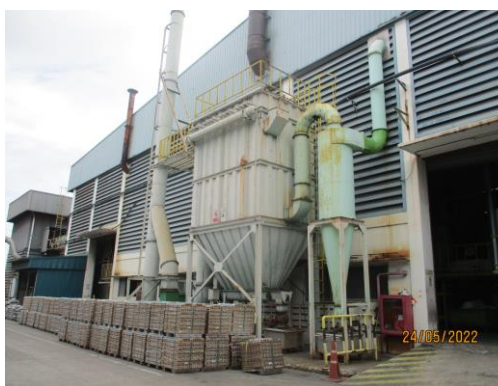
รูปที่ 2 ระบบดักฝุ่นแบบไซโคลน
