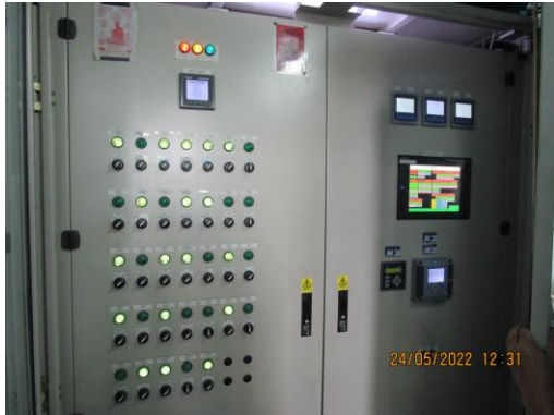
รูปที่ 15 เครื่องตรวจสอบ pH และ COD แบบอัตโนมัติ
