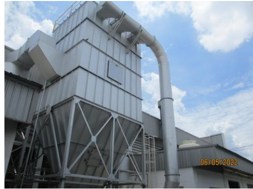
รูปที่ 1 ระบบดักฝุ่นแบบถุงกรอง
