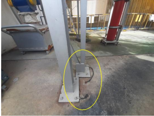
รูปที่ 29 ระบบสายดิน
