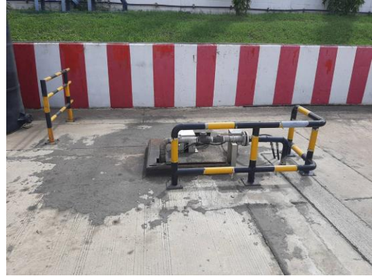
รูปที่ 12 ป่อพักน้ำเสียบนเบื่อนสารเคมีและป่อฉุกเฉิน
