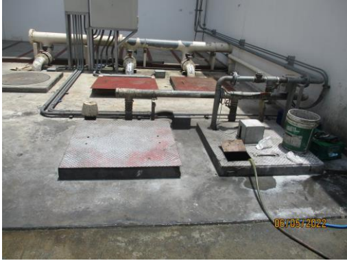
รูปที่ 12 ป่อพักน้ำเสียบนเบื่อนสารเคมีและป่อฉุกเฉิน
