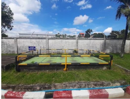
รูปที่ 9 บ่อตรวจวัดคุณภาพน้ำ (Inspection Manhole)
