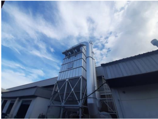
รูปที่ 1 ระบบดักฝุ่นแบบถุงกรอง
