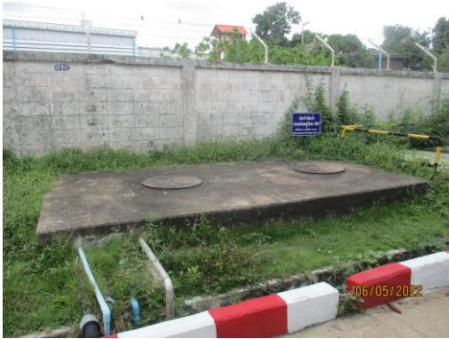
รูปที่ 10 บ่อพักน้ำทิ้งและบ่อพักน้ำทิ้งฉุกเฉิน
