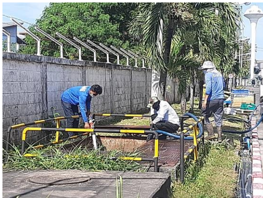
รูปที่ 6 ระบบบำบัดน้ำเสียสำเร็จรูป
