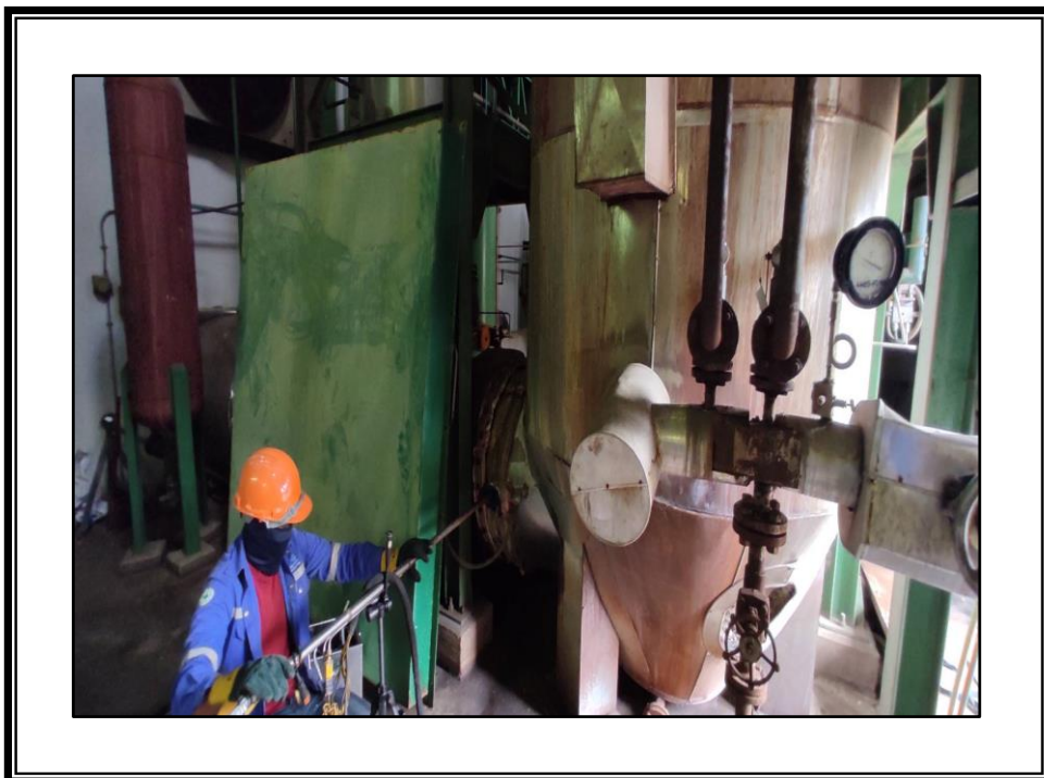
รูปที่ 3.7 จุดตรวจวัดคุณภาพอากาศจากปล่องปล่อยทิ้งอากาศเสีย บริเวณปล่อง Waste Heat Boiler ที่ต่อกับเครื่องยนต์ Caterpillar No.2 ในวันที่ 25 ตุลาคม พ.ศ. 2564
